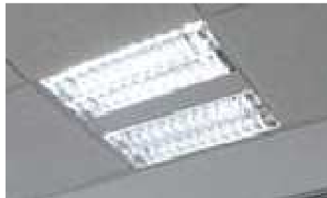
Figura 57. Luminária de 4x14W, de Embutir, modelo TBS 262/C6 – Philips. Fonte: (19) PHILIPS – Catálogo Luminárias Indoor.
