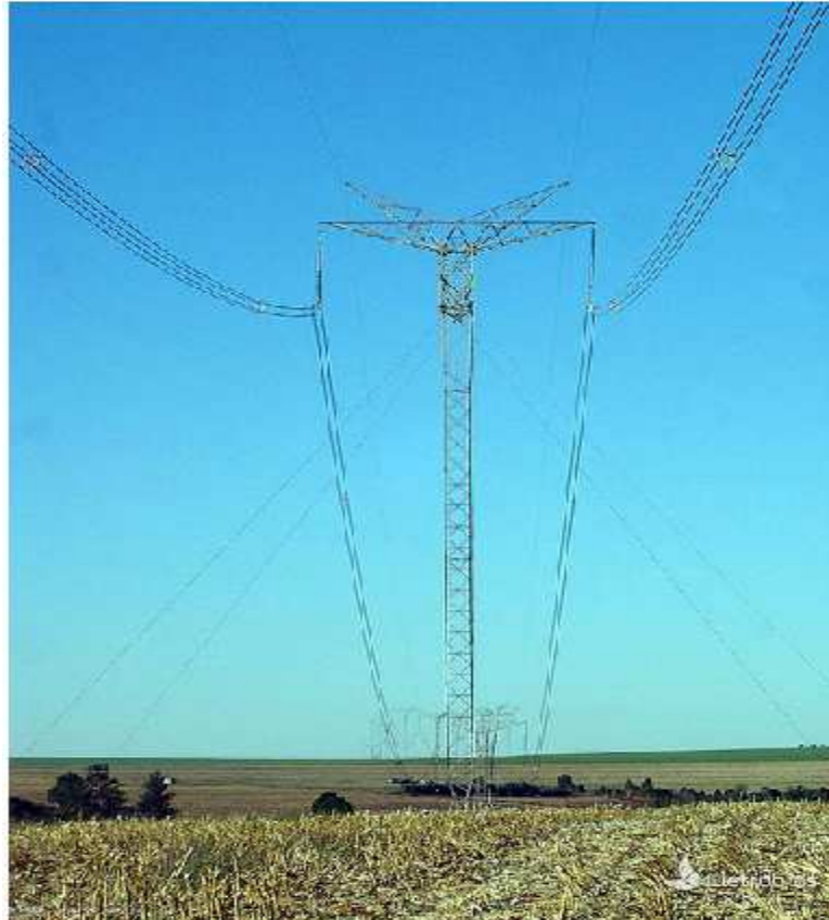
Figura 3 – Linha de Transmissão composta por estruturas Autoportantes
