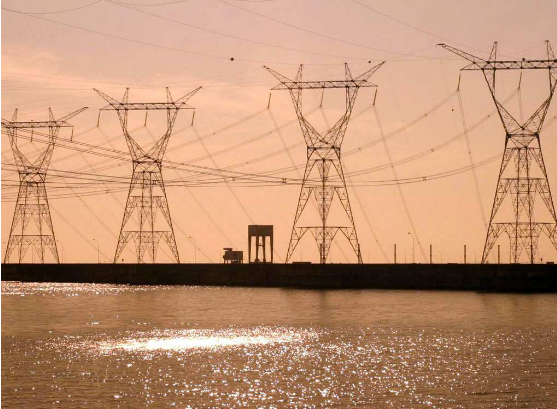
Figura 3 – Linha de Transmissão composta por estruturas Autoportantes
