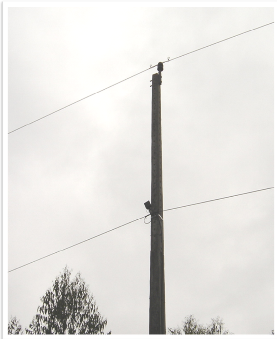
Figura 14 - Estrutura tipo U.
