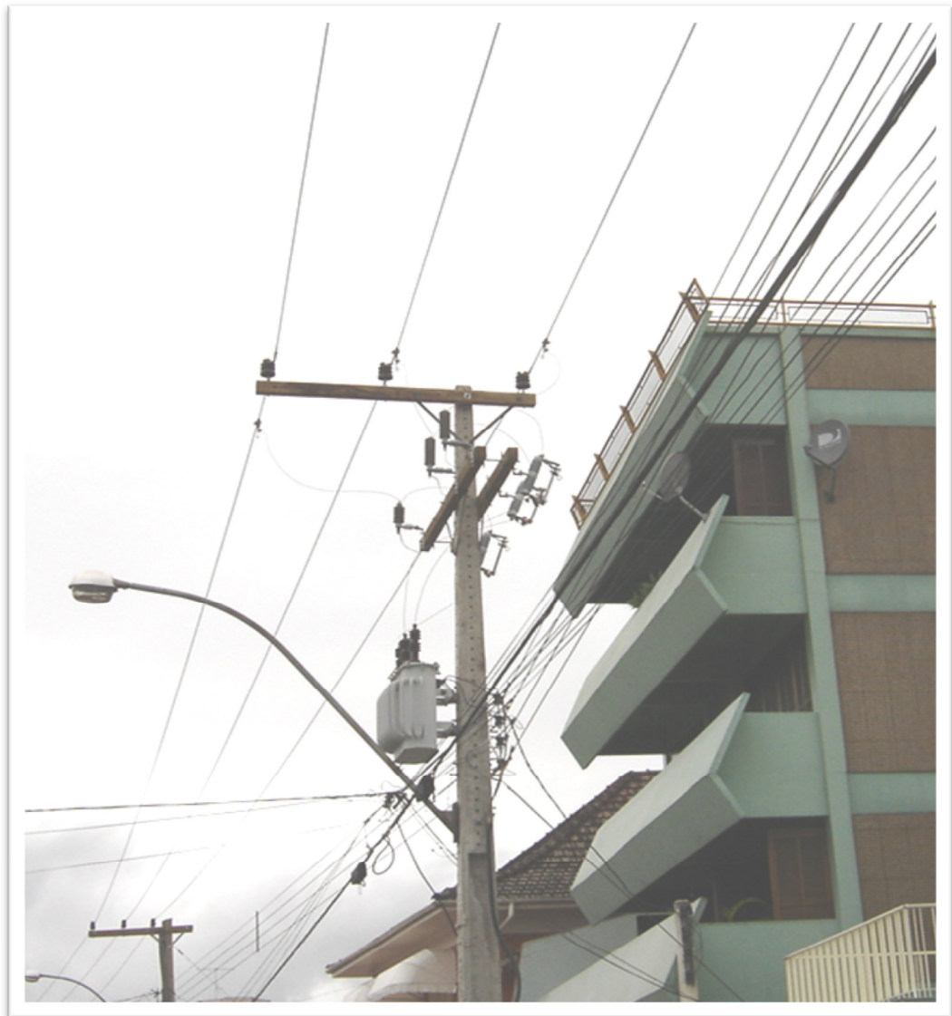
Figura 12 - Estrutura tipo M.
