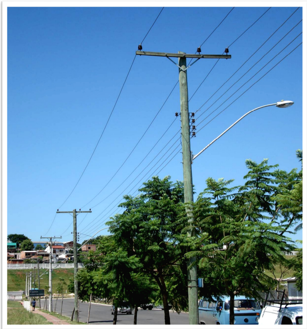
Figura 10 - Estrutura tipo N. Fonte: Noções de Estruturas e Equipamentos de Redes Aéreas de Distribuição [3]
