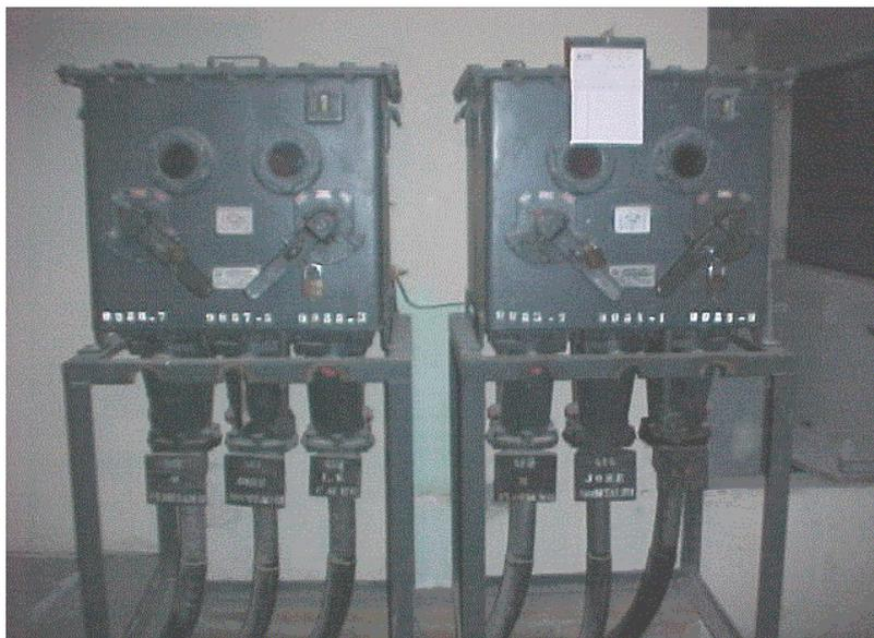
**Figura 6: Chave reversora isolada a óleo. Fonte: Rede de Distribuição Subterrânea – Engenharia e Peculiaridades.**
