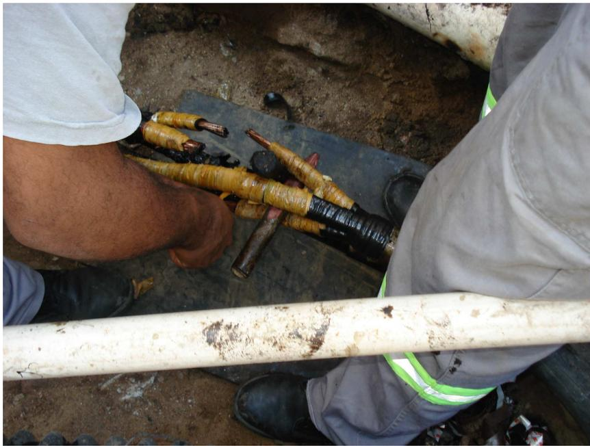
**Figura 7: Condutores isolados com papel impregnado em óleo isolante.**
