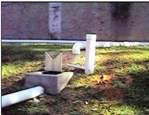
Figura 4.8 – Vertedor instalado
