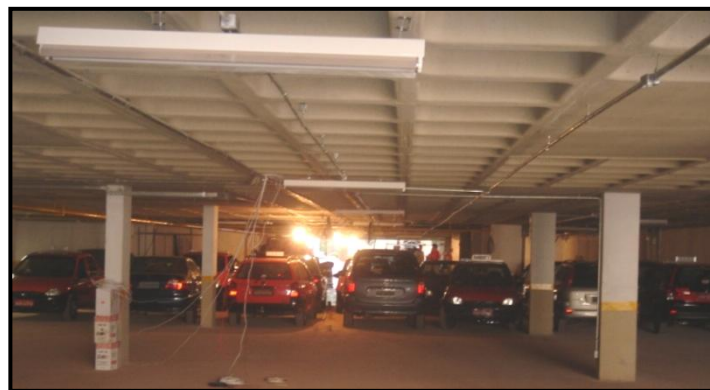
Figura 29 – Estrutura totalmente carregada
