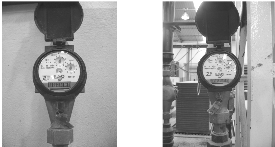
Figura 1.27 – Hidrômetros multijato magnéticos com vazão nominal de 1,5 \text{ m}^3 \cdot \text{h}^{-1} .
