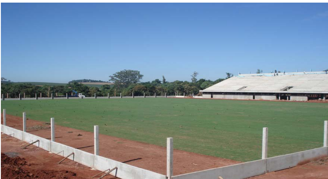
Figura 3: Foto da construção da arena do Lajeadense, foto tirada no dia 15 de março de 2011.
