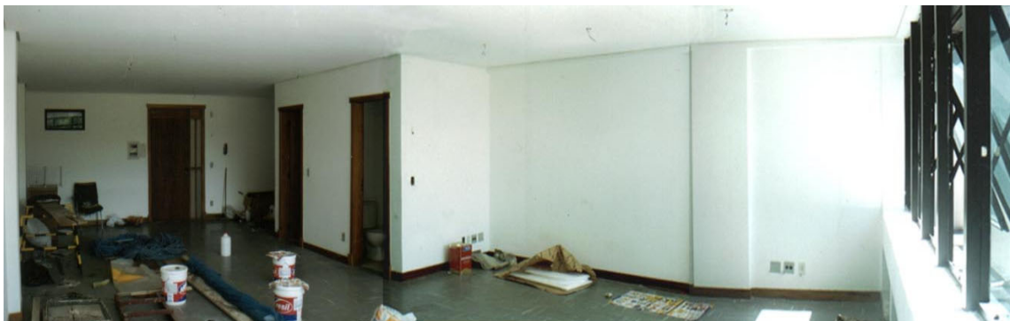
Figura 62 - panorâmica interna da sala 102 do edifício Regency com céu claro.
