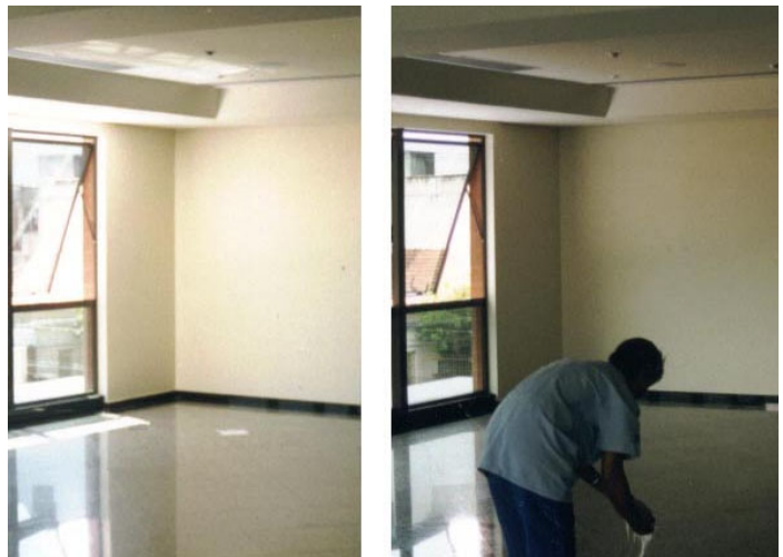
Figura 54 - céu claro e céu encoberto no 2º andar do Ed. Senge
