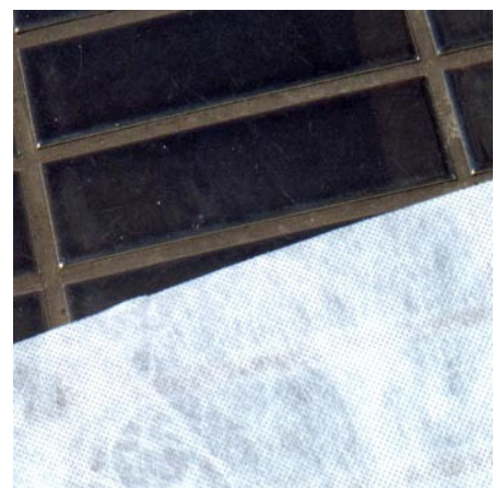
Figura 63 - superfície da marquise do edifício do Senge com o tecido branco.
