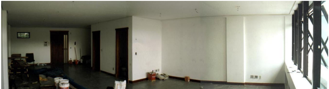
Figura 61 - panorâmica interna da sala 102 do edifício Regency com céu encoberto.
