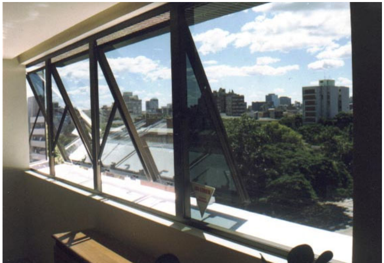
Figura 56 - vista interna da janela da sala do 4º andar do Edifício do Senge. Vidros abertos e vidros fechados.
