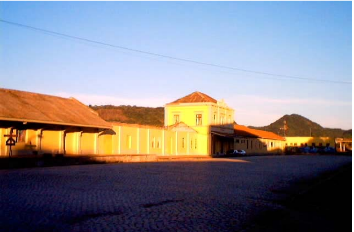
Fig. 15– Largo da Estação Ferroviária – aspecto em 2002. Foto do autor.
