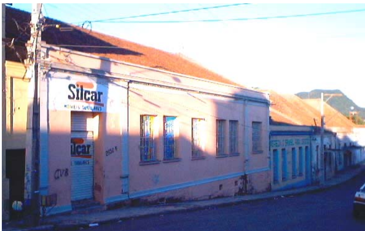
Fig. 45 – Vista do conjunto que abrigavam a administração, o armazém principal, a fábrica de confecções, a farmácia, a lenheira situado na rua Manoel Ribas. Foto do autor em 2002.
