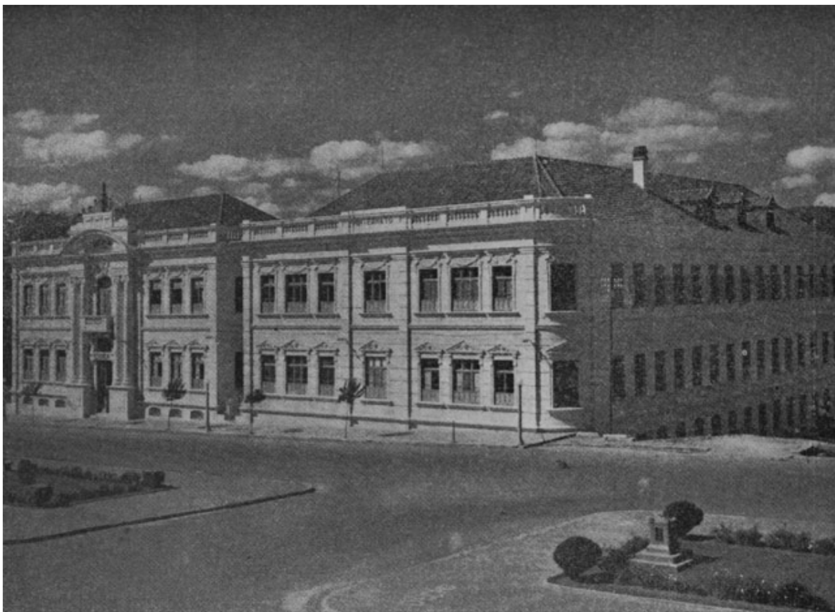
Fig. 26 – Escola Industrial Hugo Taylor já com o edifício do internato concluído. Fonte: CEVFRGS (1955) Resumo dos Empreendimentos – Visão Retrospectica, p.15.
