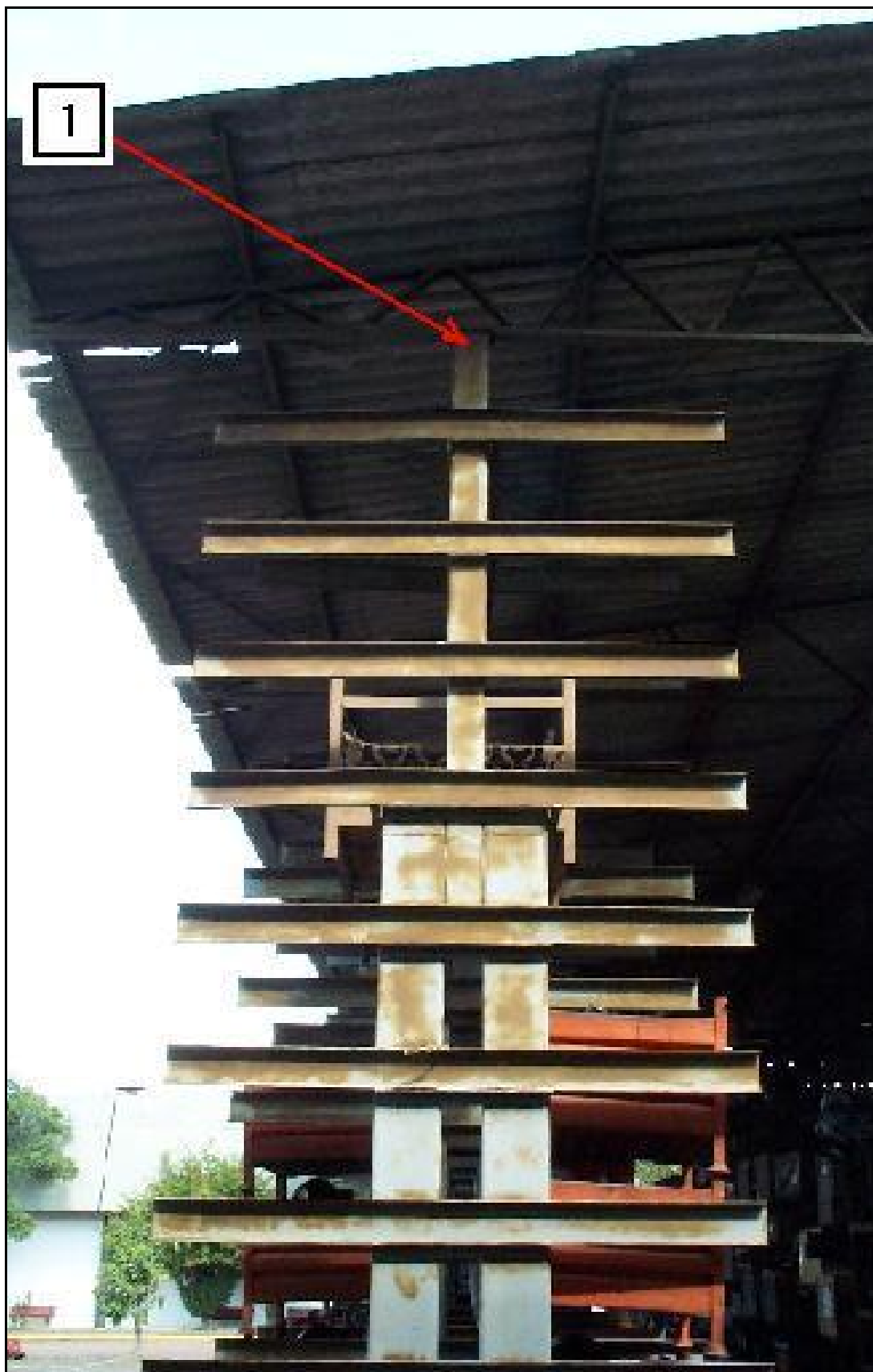
Figura 7-3 – Vista frontal da árvore metálica
