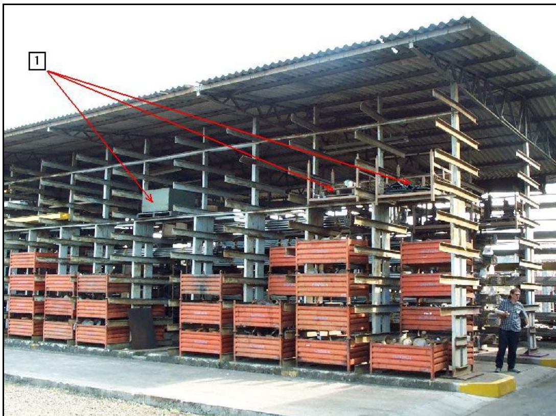
Figura 7-4 – Vista geral de todo o depósito
