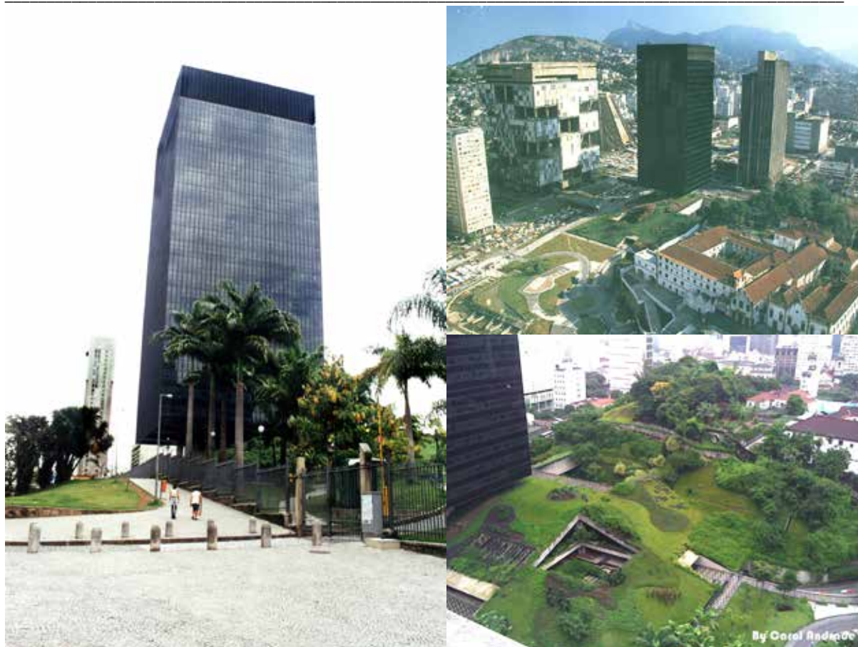
Fig. 758: vista externa do Edifício Sede do BNDES; situado na esquina da Av. Chile com a Av. República do Paraguai, no Centro do Rio de Janeiro.
