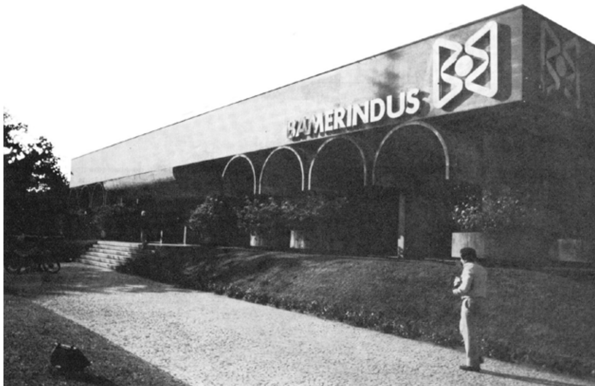
Fig.823: vista externa da agência Batel do Banco Bamerindus, edifício que baseia sua expressão nos elementos em concreto aparente, entre estes as abóbadas seriadas que atuam como quebra-sol.
