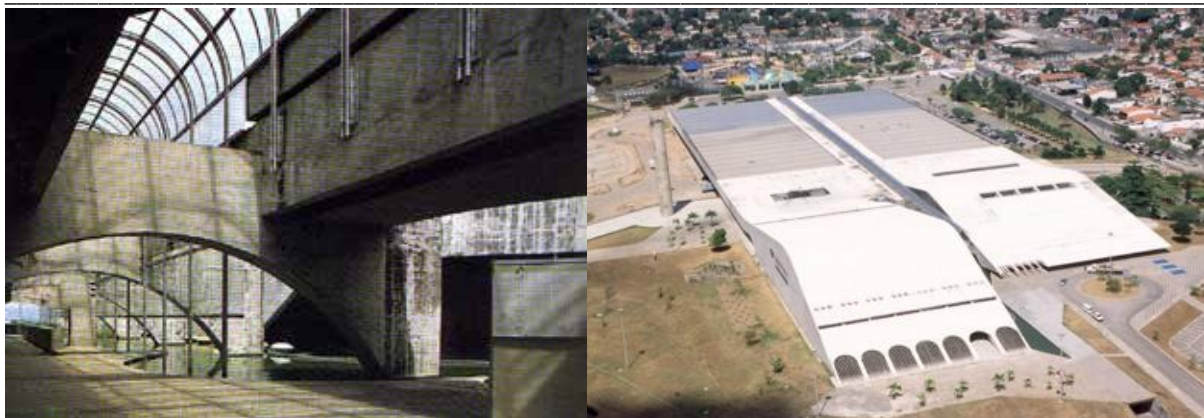
Fig.866: eixo de circulação central comum aos dois pavilhões (vista da praça de acesso frontal).
