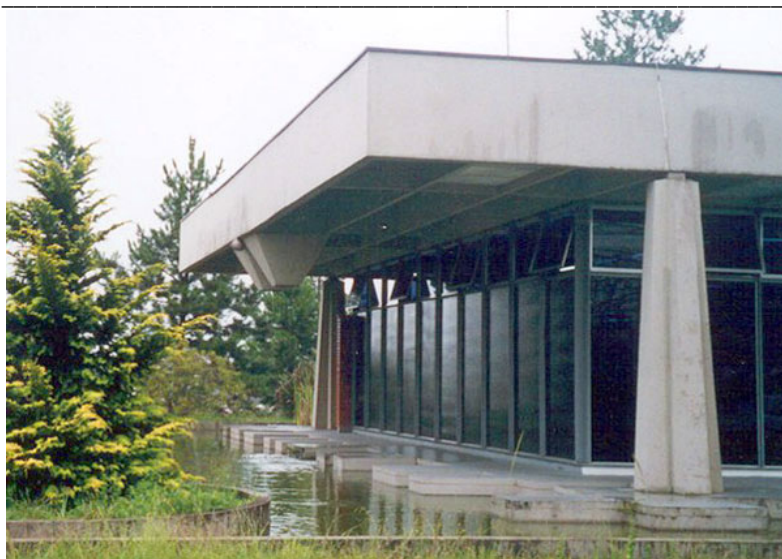
Fig.550: Estação Rebaixadora da Copel; vista atual do edifício.
