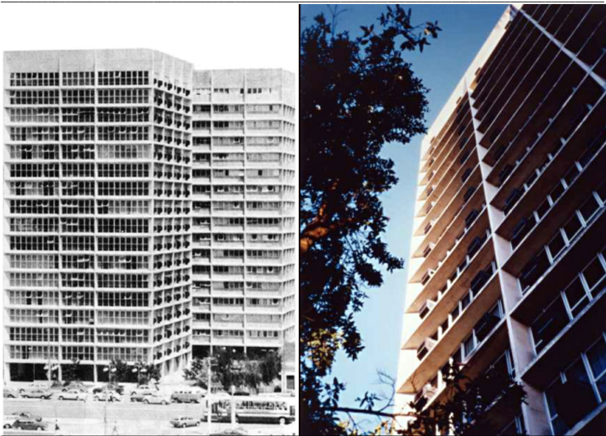
Fig.789: vista do conjunto de edifícios Conrado Riedel. Observar que, embora se utilize o mesmo sistema estrutural, o fechamento dos vãos livres se faz diferente: mais aberto, no edifício comercial, mais fechado, no residencial. Fig.790: detalhe da fachada do edifício comercial.
