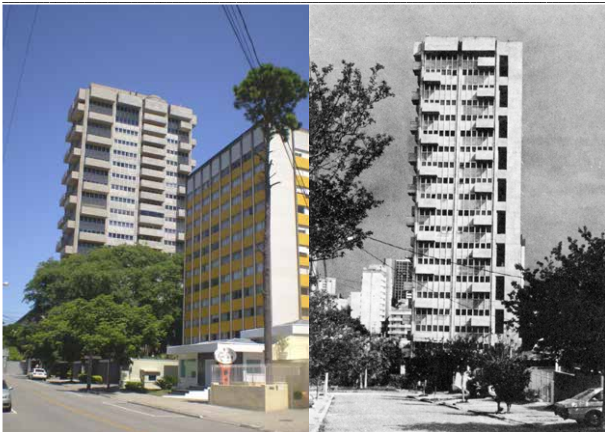
Fig. 792: vista externa do edifício à partir da Rua Dom Pedro II. Exoestrutura e varandas ritmadas em concreto aparente.
