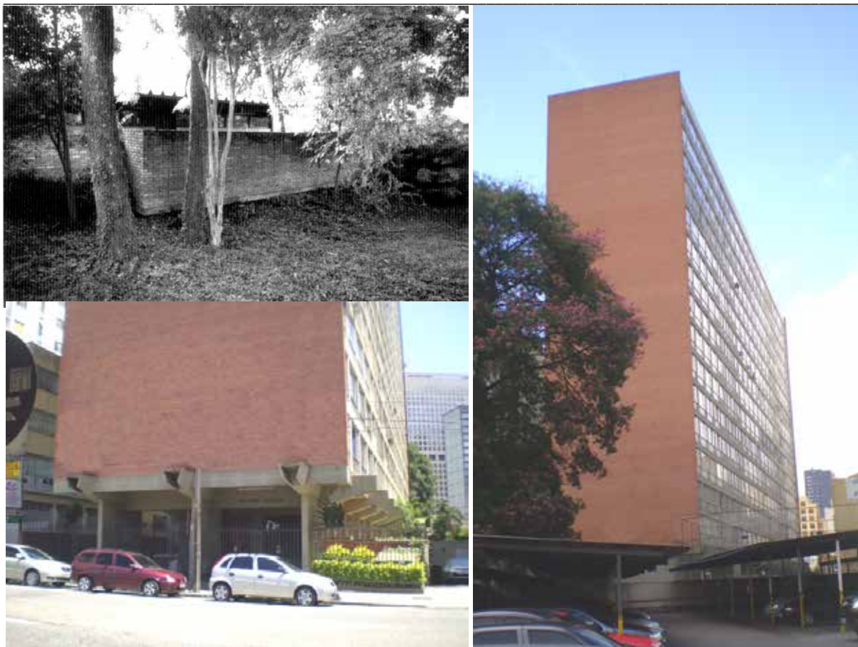
Fig.62: Henrique Panek; Casa do Arquiteto (1959), Curitiba, Rua Carmelo Rangel. Uso de materiais naturais como o tijolo à vista, a madeira e a pedra bruta. Vista externa do edifício.
