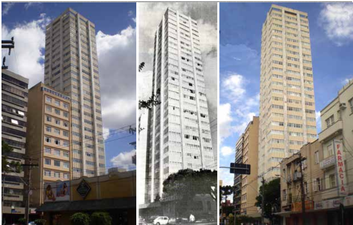
Fig.664, 665 e 666: Edifício Rio de Janeiro; torre bastante esbelta de 25 andares, sendo um apartamento por andar. Os pavimentos tipo ocorrem sob planta quadrada de 16 metros de lado. As lajes nervuradas em dois sentidos são suportadas por dois pilares em cada face, de modo a preservar os cantos em balanço.
