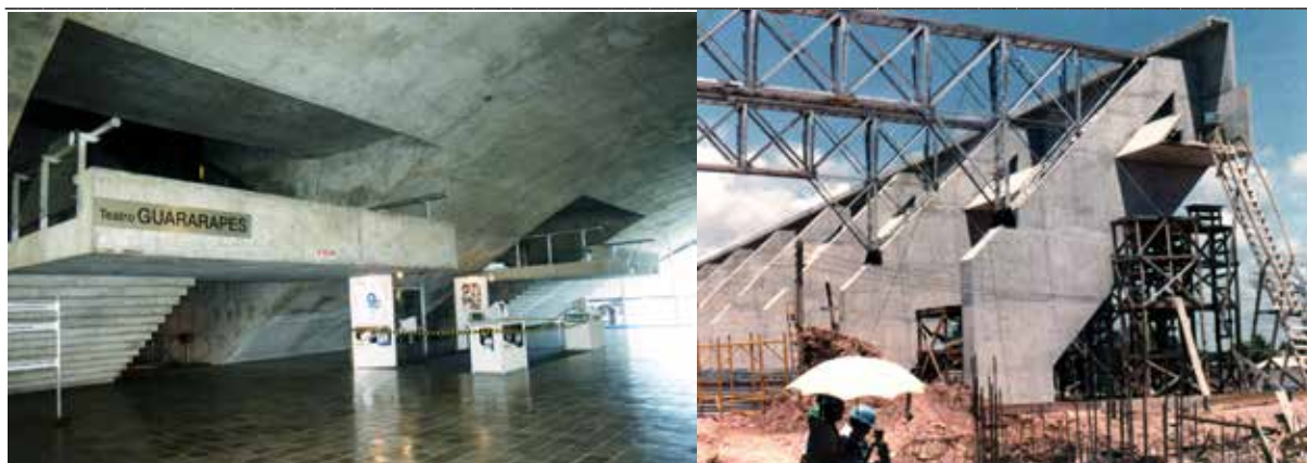
Fig.870: vista do acesso ao Teatro Guararapes; as duas escadas conduzem ao balcão. O concreto aparente apresenta-se como material preponderante.
