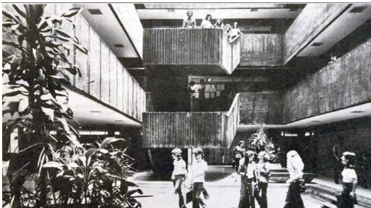
Fig.624: Escola Israelita Brasileira (Leo Grossman): vista do vazio interno de três pavimentos de altura. Destaque para a escada de dois lances, em concreto aparente, suspensa apenas pelos parapeitos.
