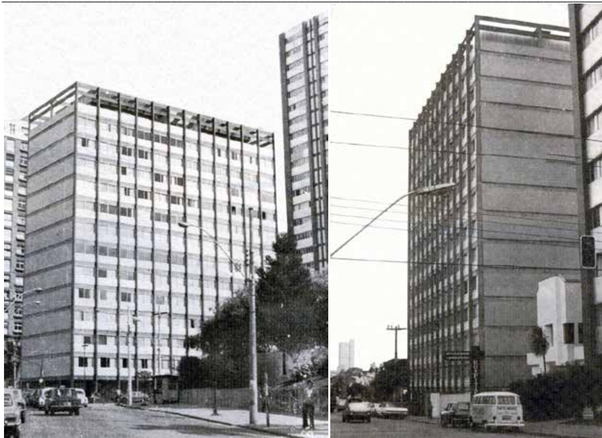
Fig.332: Edifício Panorama (1966), vista promovida pela perspectiva da Rua XV de Novembro. A estrutura em concreto armado surge totalmente exposta nas fachadas do edifício, com especial destaque para os pilares frontais, externos ao corpo do monobloco, e à gaiola de vigas e pilares, presente na cobertura.
