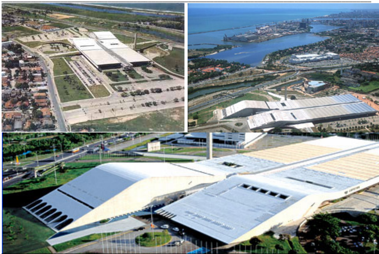
Fig. 856: vista posterior do Centro de Convenções de Pernambuco. Dois pavilhões paralelos interligados por eixo de circulação.
