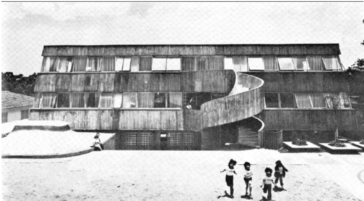
Fig. 621: Escola Israelita Brasileira: vista posterior do edifício, que se adapta ao terreno em forte declive por meio de platôs. O elemento que se expande junto ao térreo, semi-enterrado e iluminado por gazebo superior, é a sala de culto religioso.
