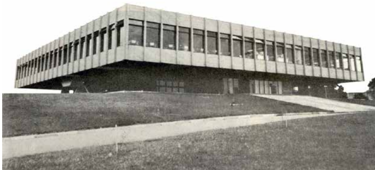
Fig.481: Vista externa da Academia de Polícia Militar do Paraná; edifício tipo apartamento elevado sobre pilotis.
