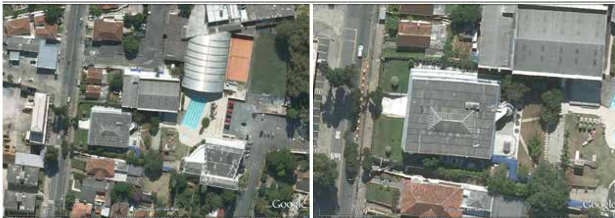
Fig.622: vista aérea retirada do Google Earth , representado a inserção do edifício no contexto urbano. Observar a vizinhança do Clube Israelita, sociedade que permite à escola o uso de suas estruturas esportivas.
