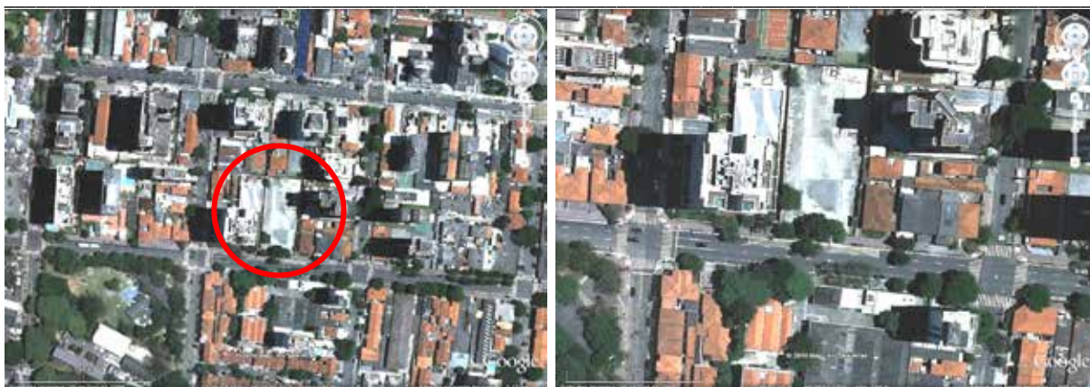
Fig.886: foto aérea retirada do Google Earth representando o tecido urbano da região.
