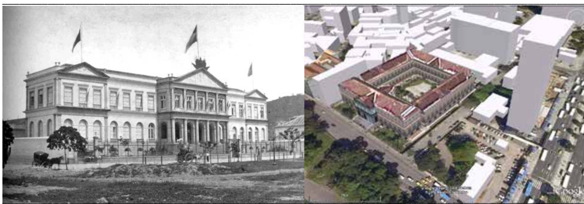
Fig. 647: fotografia do edifício sede da Casa da Moeda (1965-1869), retirada da Praça da República.
