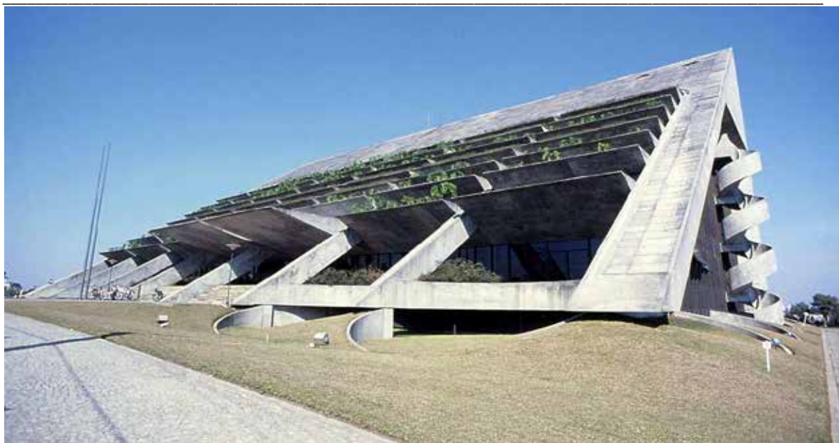
Fig.849: vista externa do Edifício-sede da ACARPA, situado em parte elevada e pouco ocupada do Bairro Cabral.
