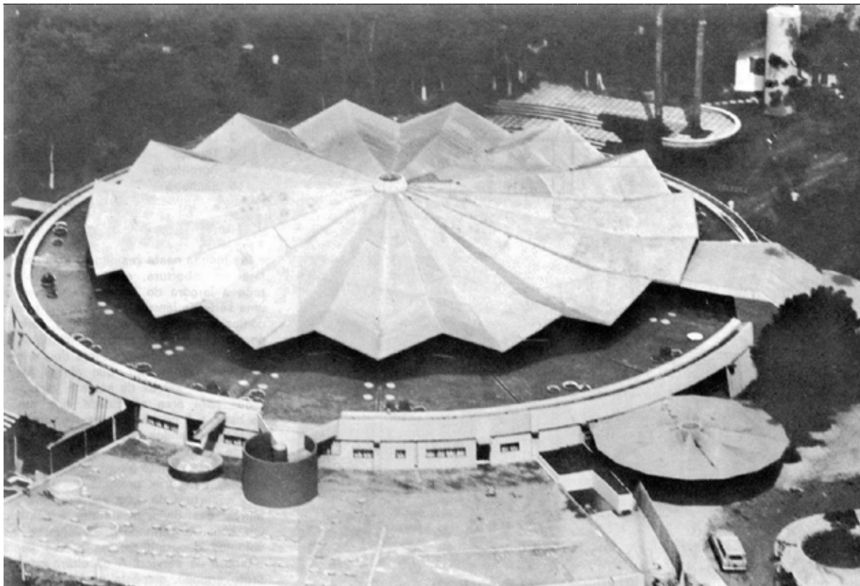
Fig.341: vista aérea da sede social do Clube Curitibano, projetada em 1966. Destaque-se a grande cobertura circular em laje de concreto aparente, plissada, de apenas 7 cm de espessura, apoiada sobre 16 pilares, de modo a proporcionar um vão livre interno de 36,0 metros e um amplo balanço periférico.
