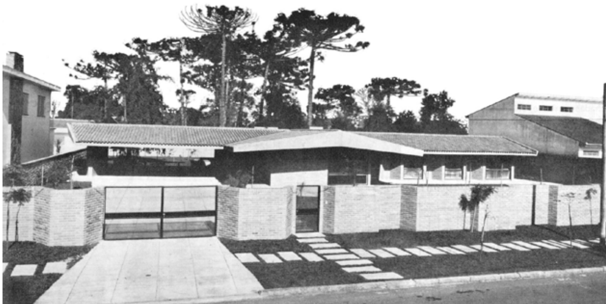
Fig.674: vista externa da residência: destaque para as duas coberturas entrecruzadas de forma a possibilitar amplos beirais.
