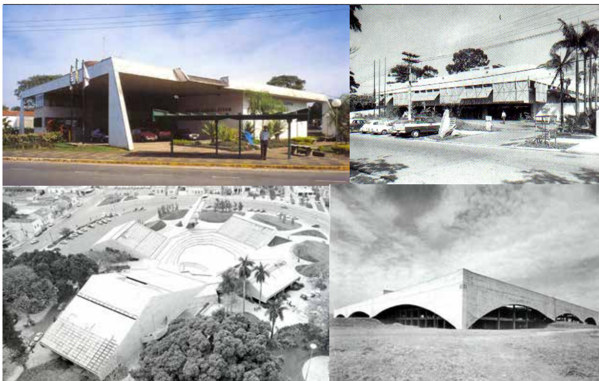
Fig.83: Fábio Penteadó e José Ribeiro; Fórum de Araras, Araras, SP. (1960). Vista Externa.
