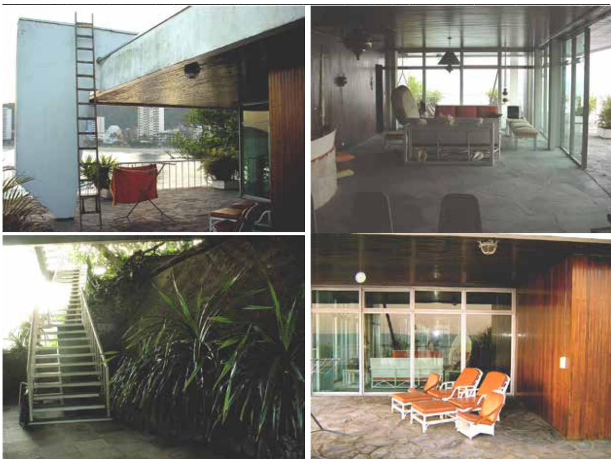
Fig.284: vista de um dos apoios dos pórticos da cobertura; Fig.285: vista da sala social e varandas anexas;
