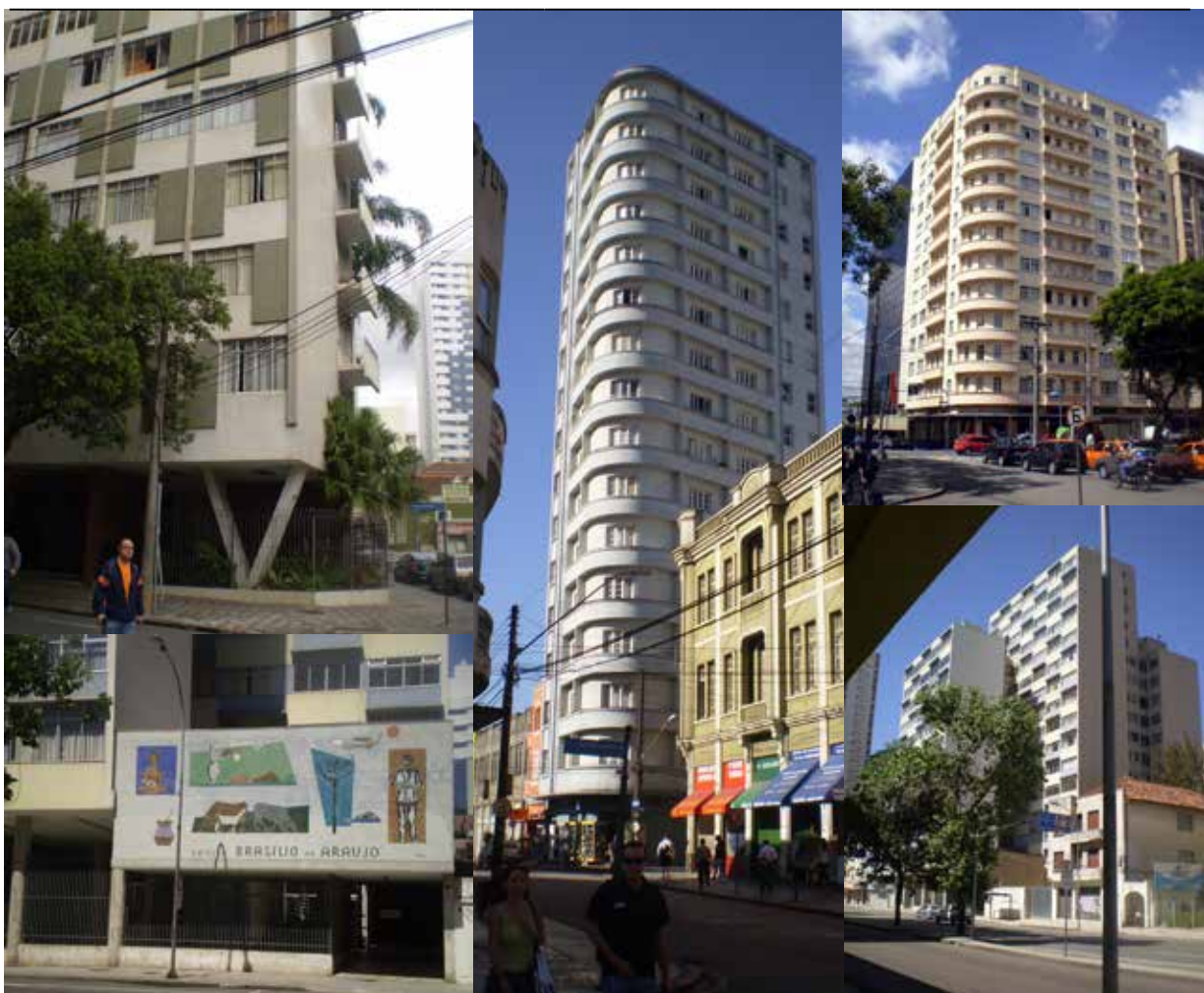
Fig.334: (coluna esq. sup.) Edifício Anita (1963-1964), de André Masini; Fig.334a: (coluna esq. inf.) Mural existente no acesso do edifício Brasília de Araújo (1961-1962); Fig.334b: (coluna do meio) Ed. Rosa Ângela Perroni (1950), de Romeu Paulo da Costa; Fig.334c: (coluna dir. sup.) Ed. Marumby (1947), de Romeu Paulo da Costa; Fig.334d: (coluna dir. inf.) Ed. Brasília de Araújo (1961-1962), de André Masini.
