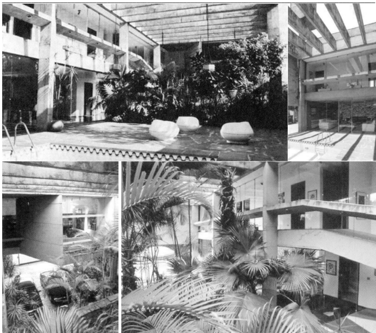
Fig.896: Casa Edgard Niclewicz (1979): vista do jardim interno, protegido por estrutura em concreto aparente, recoberta por pérgola. Ao lado observa-se a circulação superior, vedada por vidros temperados, que conduz aos quartos da casa.
