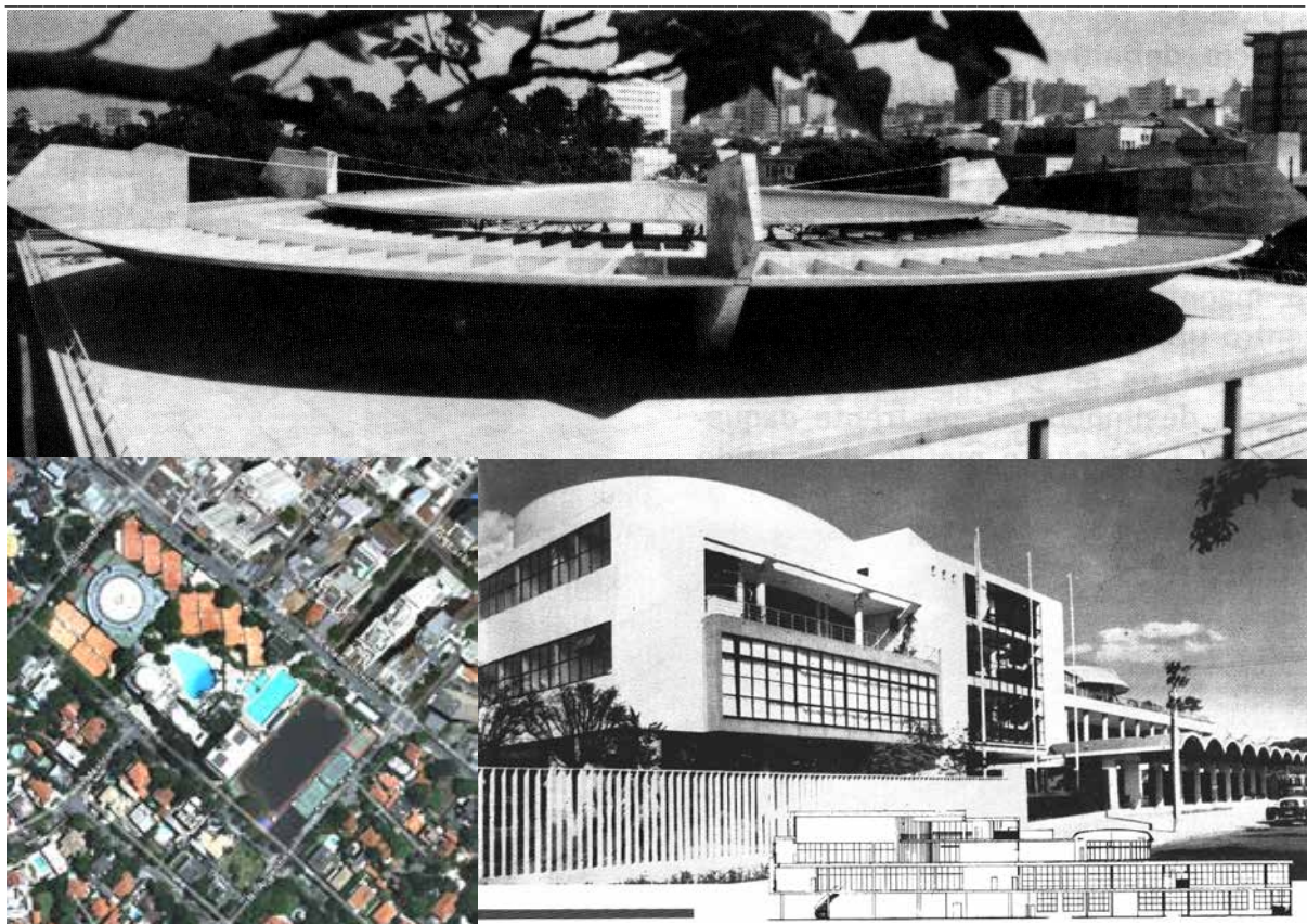
Fig.108: Vista geral da cobertura do ginásio do Clube Atlético Paulistano, projetado por Paulo Mendes da Rocha e João Eduardo de Gennaro (primeiro lugar no concurso). Note-se que os seis grandes pilares em forma de leme de navio mantém a cobertura em forma de disco vazado à pouca altura da plataforma elevada.
