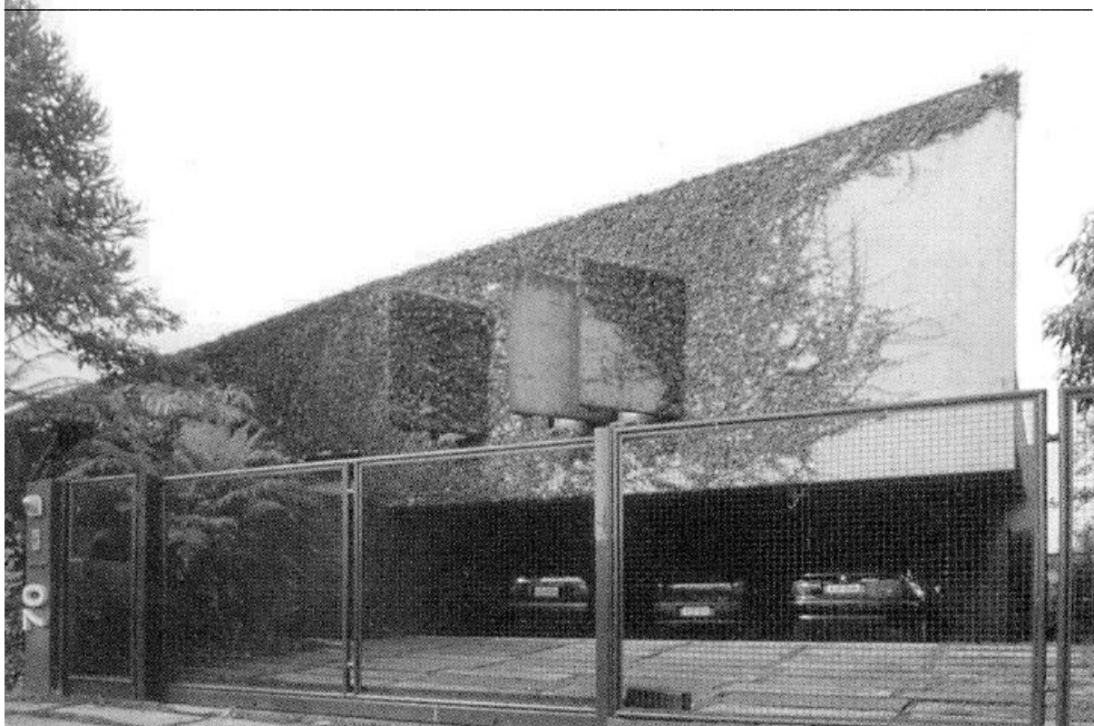
Fig. 771: vista externa da casa, que, por meio de empena em concreto aparente, se apresenta bastante opaca para a rua.
