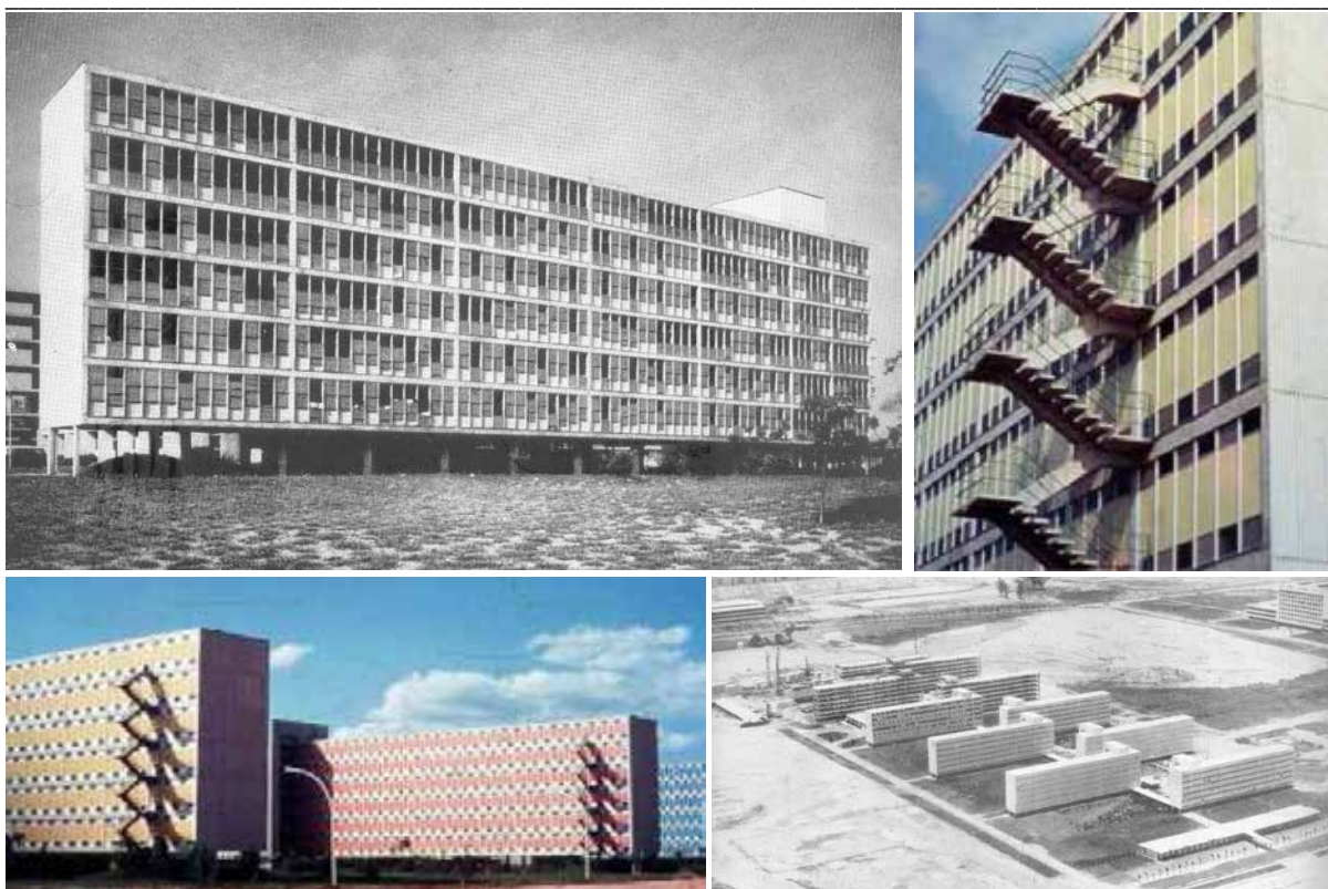
Fig. 145: face leste de um dos pavilhões; destaque para o sistema de venezianas em madeira, tipo guilhotina.
