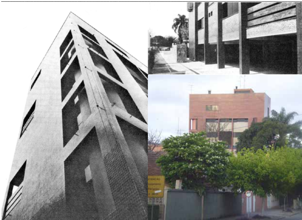
Fig. 949: vista do canto noroeste do edifício, feito por grelha estrutural que se sobrepõe ao volume cilíndrico da escada.
