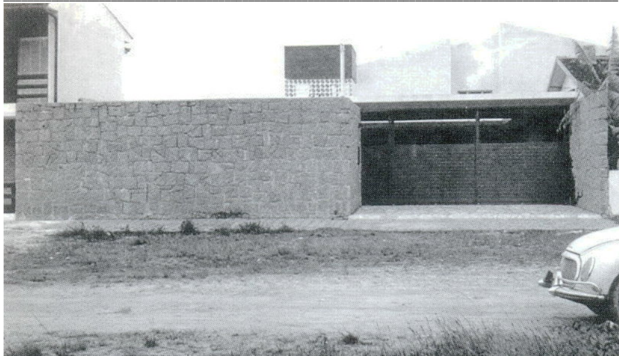
Fig.161: vista externa da Casa Giocondo Vilanova Artigas, construída em 1961, no Balneário de Caiobá, litoral do Paraná, e demolida em meados da década de 1980. Pode-se perceber o muro de pedras que resguarda o jardim frontal de serviço e, ao fundo, a fina laje de cobertura, recoberta por lâmina d'água.
