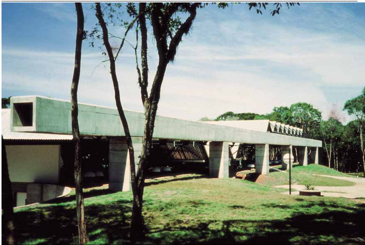
Fig.810: vista externa do edifício sede da Associação dos Economiários do Paraná (1976). Observar a viga em seção tubular quadrada, mediante caixão perdido. A cobertura, por sua vez, adapta-se aos desníveis do terreno, de acordo com a necessidade de cada parte do programa.
