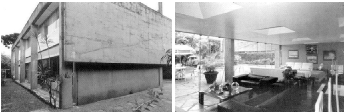
Fig.900: vista externa da face posterior do edifício, arrematado por ampla empena cega em concreto aparente, solução também empregada na face frontal da casa. Ao lado observa-se, também, as aberturas dos quartos, recuadas dos apoios.
