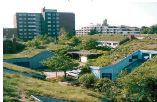
Telhados verdes em residências.
