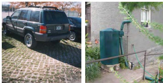
Pavimento permeável em um estacionamento (esquerda) e microrreservatório em uma residência (direita).
