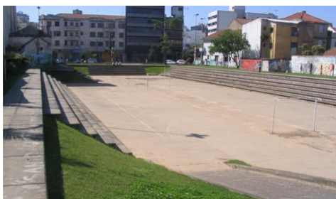
Reservatório de amortecimento (piscinão) – Porto Alegre.
