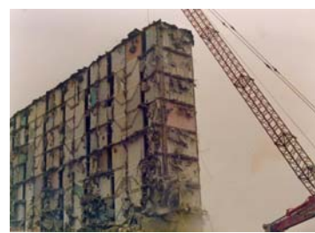
(c) Vista demolição bloco
