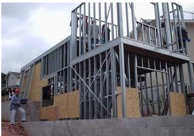
Figura 1.1 - Exemplo de edificação utilizando o sistema Light Steel Framing .
