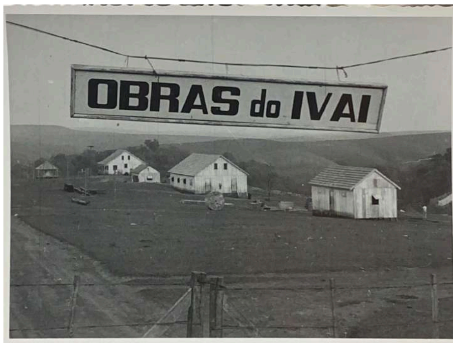
Figura 26 - Vila operária. Construção da Usina de Ivai/RS, 1951.
