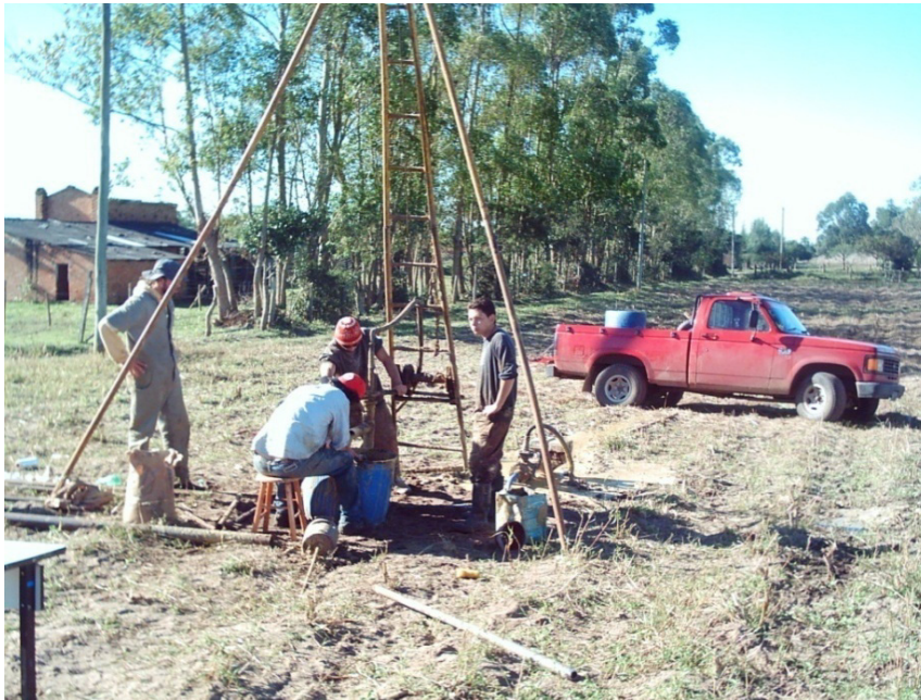
Figura 10: Foto da campanha de sondagem realizada pelo método SPT.
