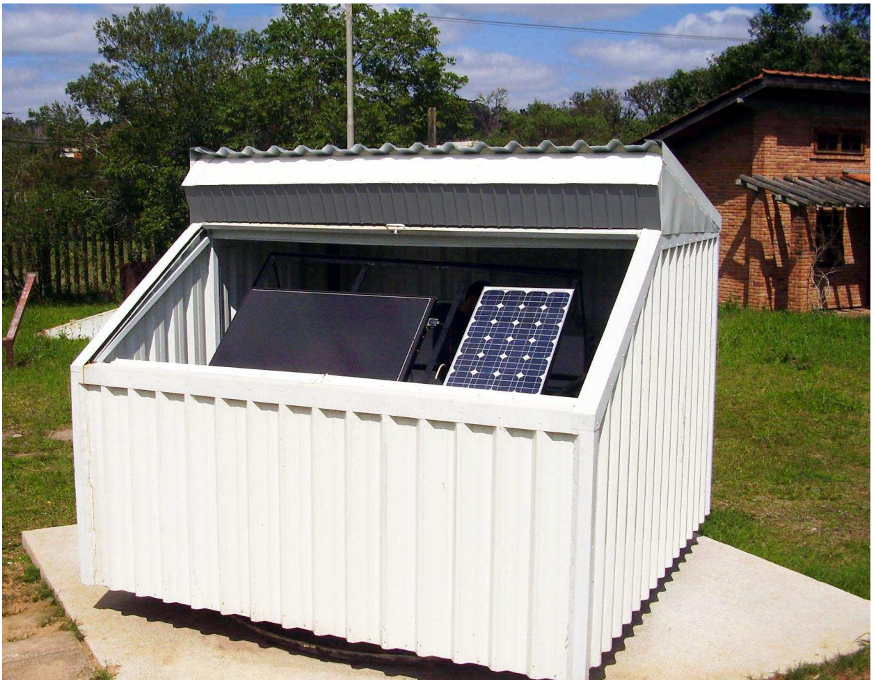
Figura 6.2 – Vista frontal da câmara climatizada para ensaio de módulos fotovoltaicos.
