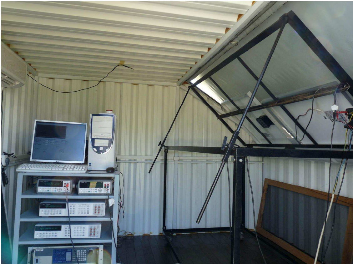
Figura 6.3 – Vista interna da câmara climatizada.
