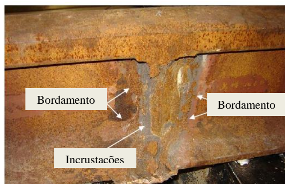
Figura 2.14 Exemplo de solda com defeito de bordamento. É observado, também, incrustação de material cerâmico no colar de solda (ROSA 2008).
