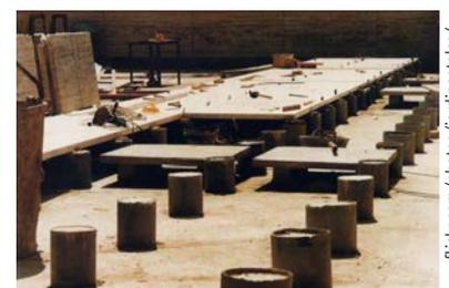
COLOCAÇÃO DO PAVIMENTO FLUTUANTE DE TRAVERTINO ROMANO SOBRE OS CILINDROS DE CONCRETO, 1985.
