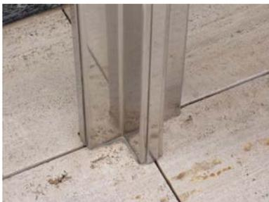
**IMAGEM DE UM DOS PILARES DO PAVILHÃO RECONSTRUÍDO. A SEÇÃO EM CRUZ FOI MANTIDA, MAS O MATERIAL FOI SUBSTITUÍDO POR AÇO INOXIDÁVEL POLIDO.**
