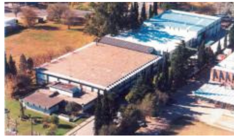
WEG EQUIPAMIENTOS ELECTRICOS S.A. - UNIDADE
