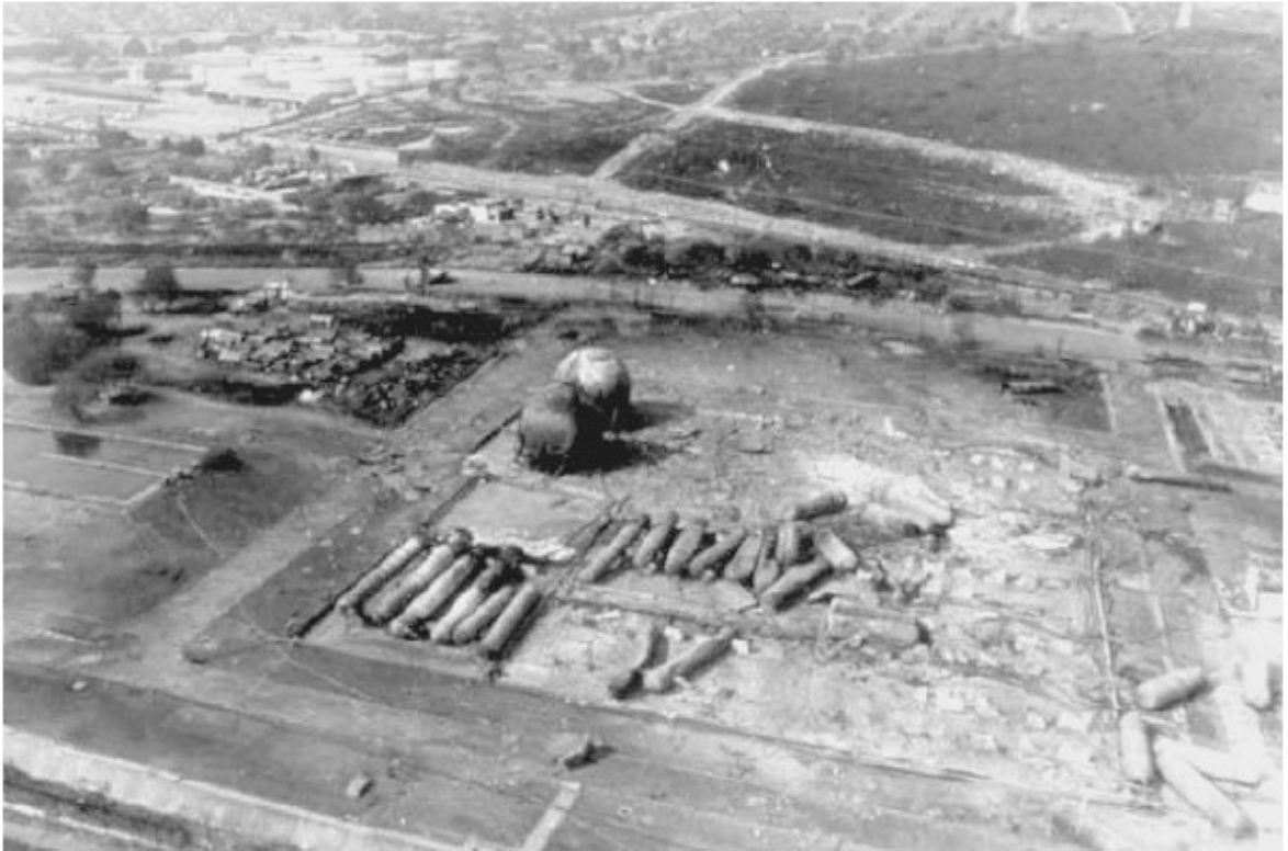
Figura 2.4 – PEMEX após o incidente de 18 de novembro de 1984. (Fonte: CCPS, 2003).
