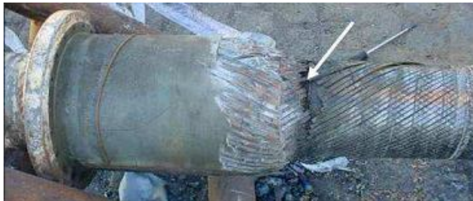
Figura 2: Indicação da região de rompimento da armadura de tração [Bueno, 2009].
