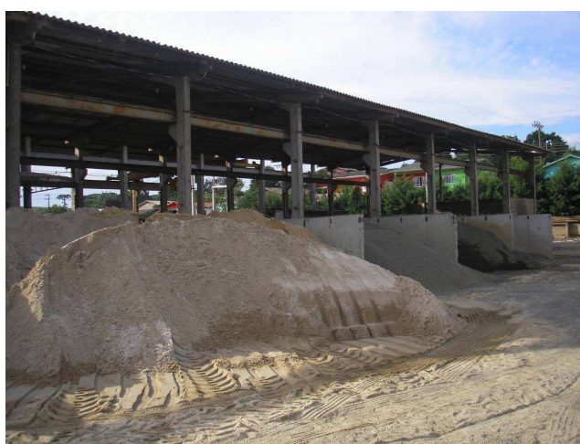
Figura 15 - Armazenagem dos agregados - areia e brita.
