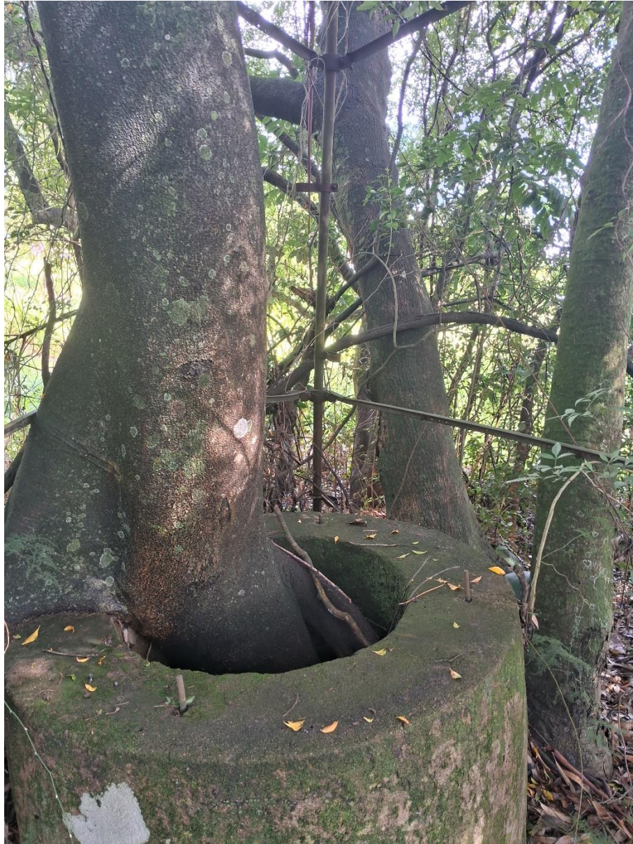
Figura 2 – Antigo poço utilizado pela comunidade dos bairros Querência e Jardim Krahe de Viamão.
