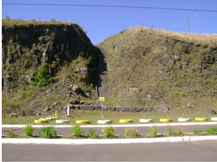
Figura 15 - Imagem da passagem do gasoduto nas proximidades da cidade de São Francisco de Paula.
