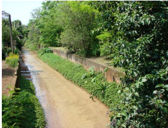
Foto 15 - Presença de vegetação característica de banhado dentro do leito canalizado do arroio. Águas turvas. Margens com vegetação exótica e nativas plantadas, e gramíneas.
