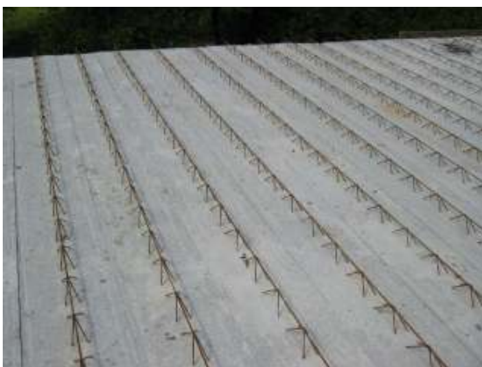
Figura 28: laje executada com pequenos painéis treliçados (LIMA, 2010)
