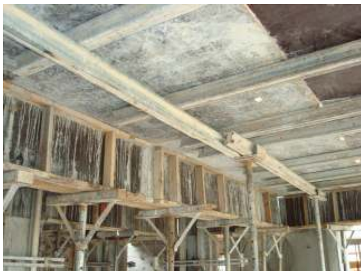
Figura 18: escoramento e barroteamento das vigas e laje
