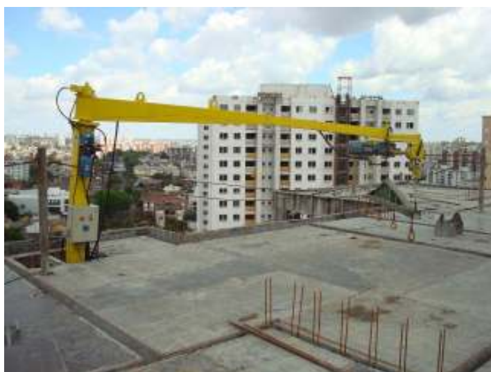
Figura 14: equipamento utilizado para transporte vertical de materiais
