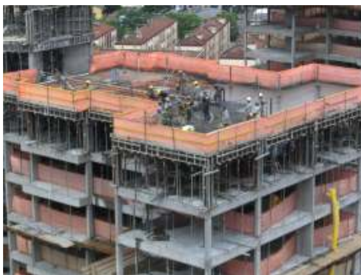
Figura 22: concretagem das vigas e laje de um setor do pavimento tipo da obra estudada
