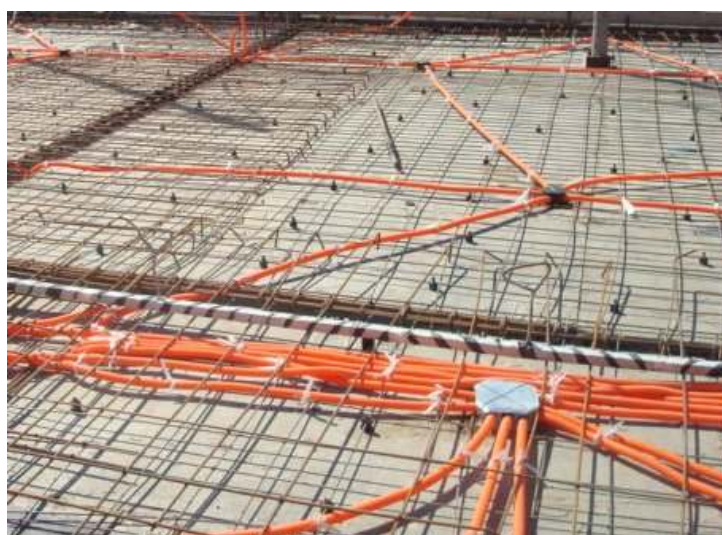
Figura 21: detalhe do posicionamento da armadura da laje, tubulações e caixas
