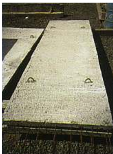
Figura 10: detalhe da rugosidade e das alças de içamento da pré-laje protendida (CONSTRUTORA PREMOLD LTDA, 2010)
