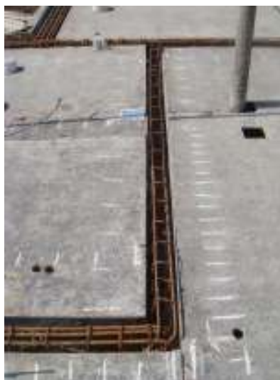
Figura 20: colocação da armadura das vigas
