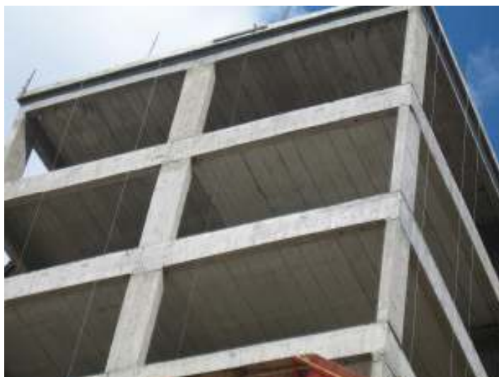
Figura 29: estrutura de edifício executado com pré-lajes (LIMA, 2010)
