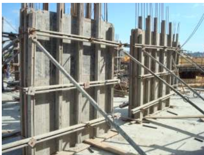
Figura 16: etapa de fechamento e travamento das fôrmas dos pilares
