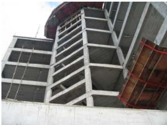
Figura 23: estrutura de concreto armado utilizando pré-lajes (LIMA, 2010)
