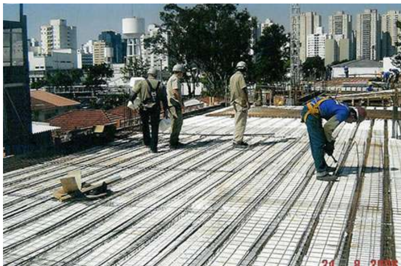
Figura 9: pré-laje treliçada com EPS (LAJES ANHANGUERA INDÚSTRIA E COMÉRCIO, 2010)
