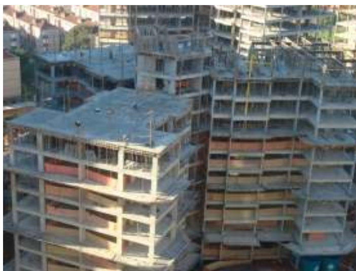
Figura 13: vista superior da execução da edificação da obra estudada
