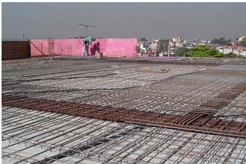
Figura 7: detalhe das pré-lajes com armadura negativa (LAJES ANHANGUERA INDÚSTRIA E COMÉRCIO, 2010)
