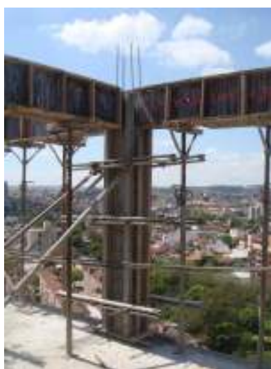
Figura 17: colocação dos fundos e laterais internas das vigas apoiados sobre as escoras e fôrmas dos pilares
