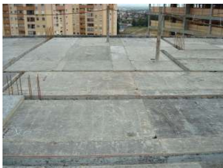
Figura 19: etapa de execução da laje com fôrmas de compensado
