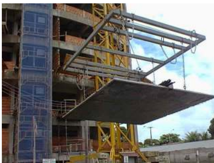
Figura 6: içamento de pré-laje (TEIXEIRA; GONÇALVES, 2005, p. 10)
