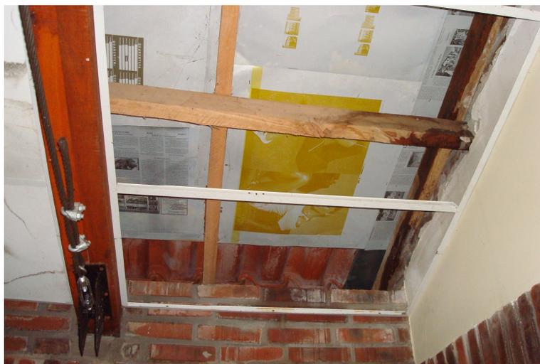
Figura 6: isolamento térmico do telhado com chapas off-set
