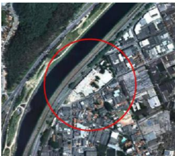
Figura A1-1: localização do Empreendimento Brookfield Towers e projeção da área ensaiada em túnel de vento (trabalho não publicado) 18
