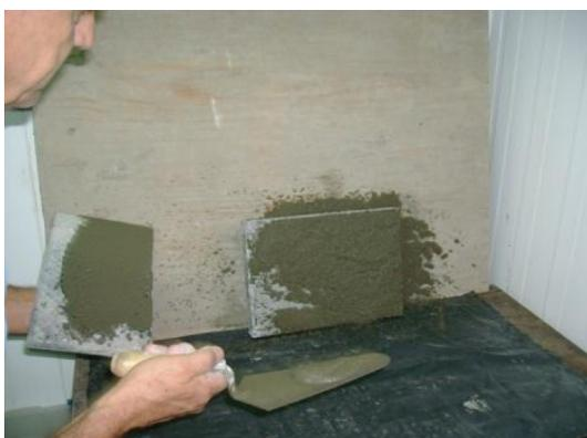
Figura 6: aplicação do chapisco lançado com colher
