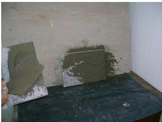
Figura 23: aplicação do chapisco lançado com colher
