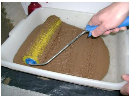
Figura 24: rolo e bandeja utilizados para a aplicação do chapisco rolado
