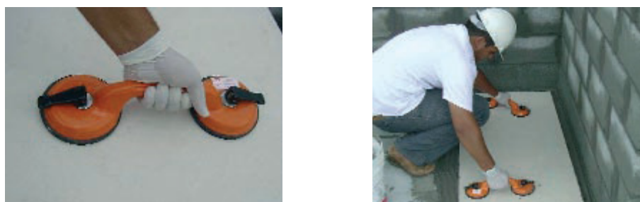
Figura 8: utilização de ventosas (PORTOBELLO S/A, 2005, p. 7)
