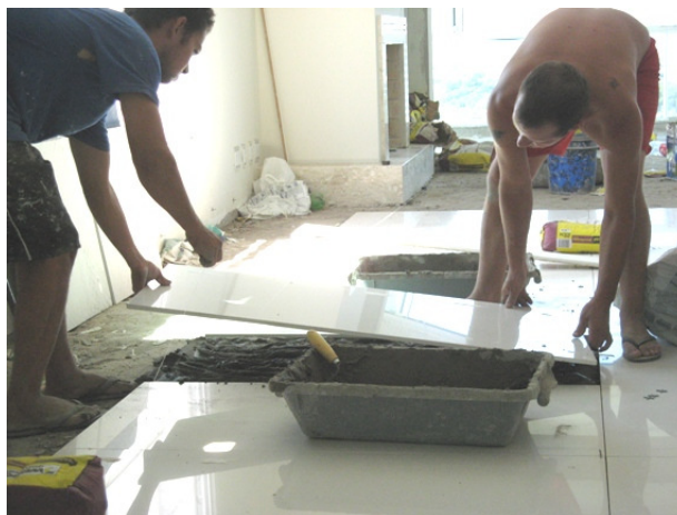
Figura 11: posicionamento da placa com ajudante
