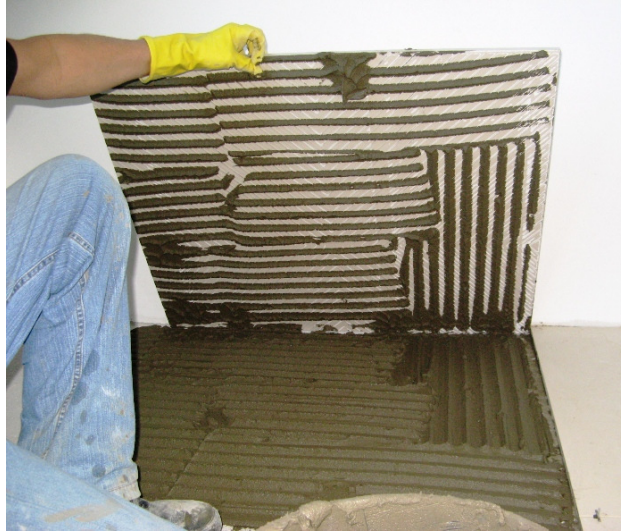
Figura 15: impregnação de argamassa colante na placa (caso 3)
