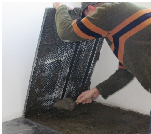
Figura 19: impregnação de argamassa colante na placa (caso 6)
