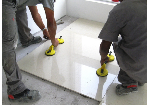
Figura 20: utilização de ventosas para assentamento de placa
