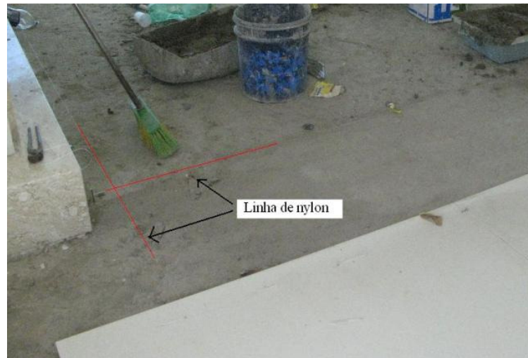
Figura 10: utilização de linha de nylon
