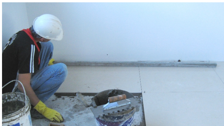
Figura 14: utilização de régua metálica
