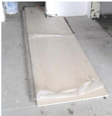
Figura 13 utilização de linha de nylon e régua metálica
