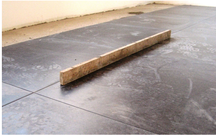
Figura 18: utilização de régua de madeira para nivelamento
