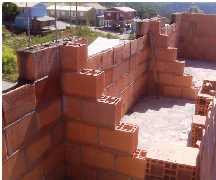
Figura 5: detalhe da elevação das paredes com blocos cerâmicos estruturais
