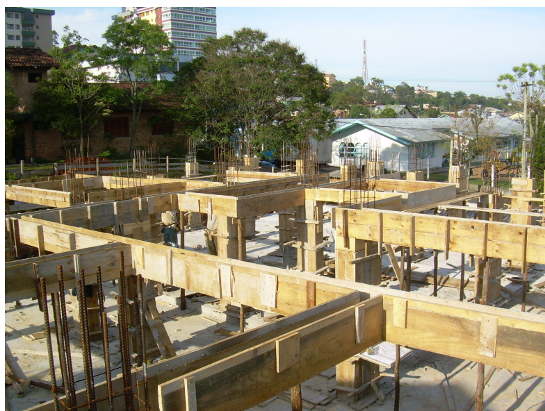
Figura 9: montagem da fôrma de madeira
