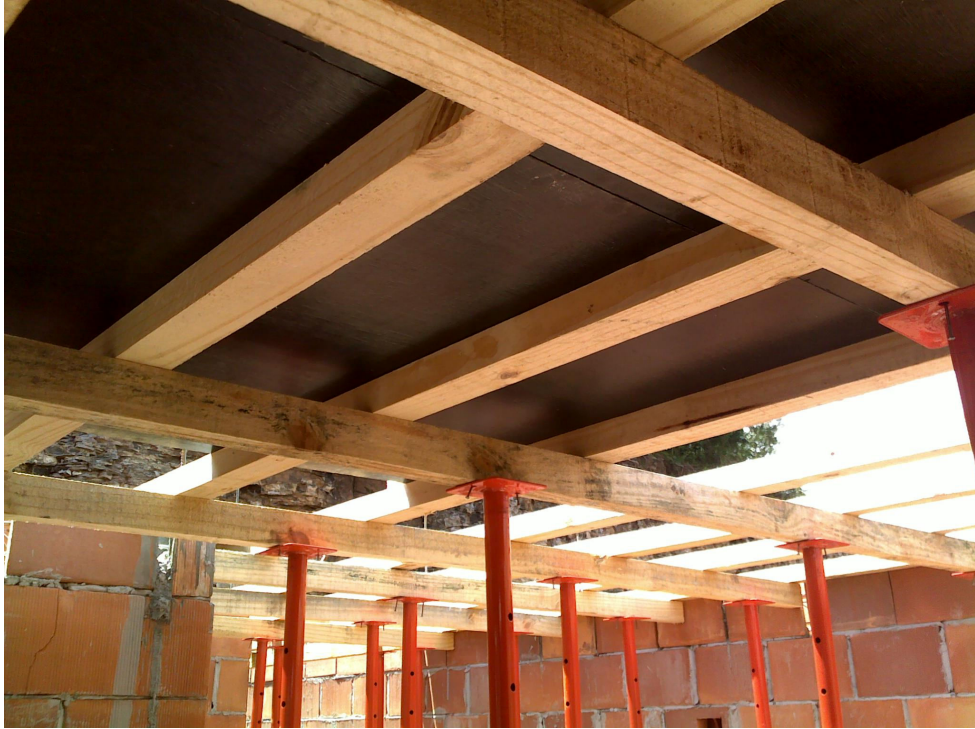
Figura 17: fôrma para laje
