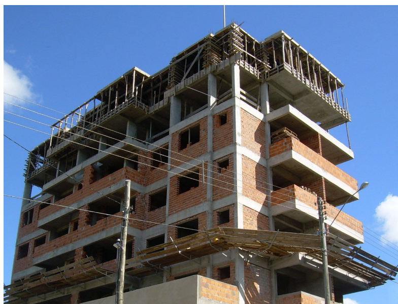
Figura 10: aspecto da estrutura em concreto armado convencional
