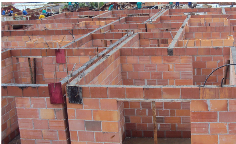
Figura 6: aspecto final da estrutura com blocos cerâmicos estruturais
