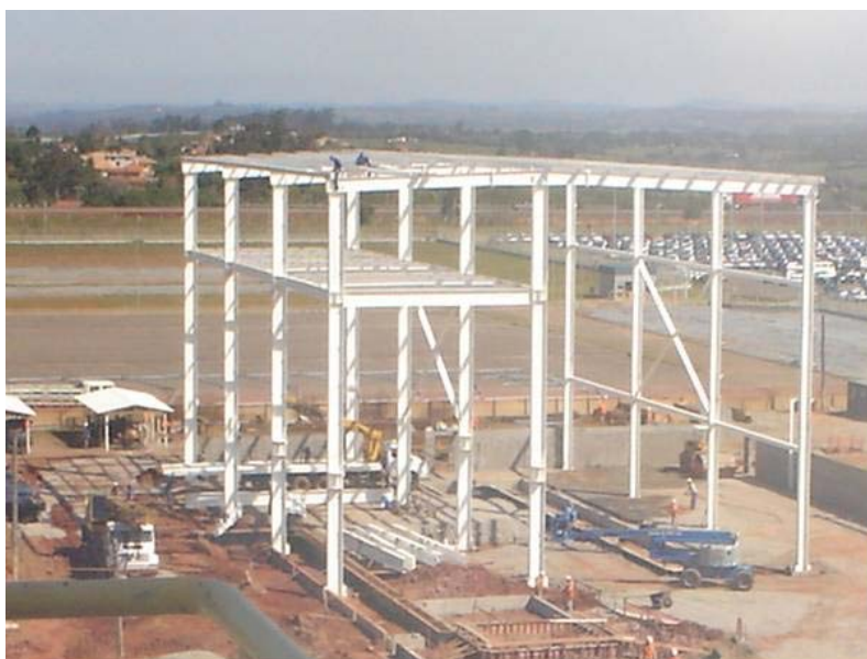
Figura 4 - Fotografia do empreendimento “b” em execução
