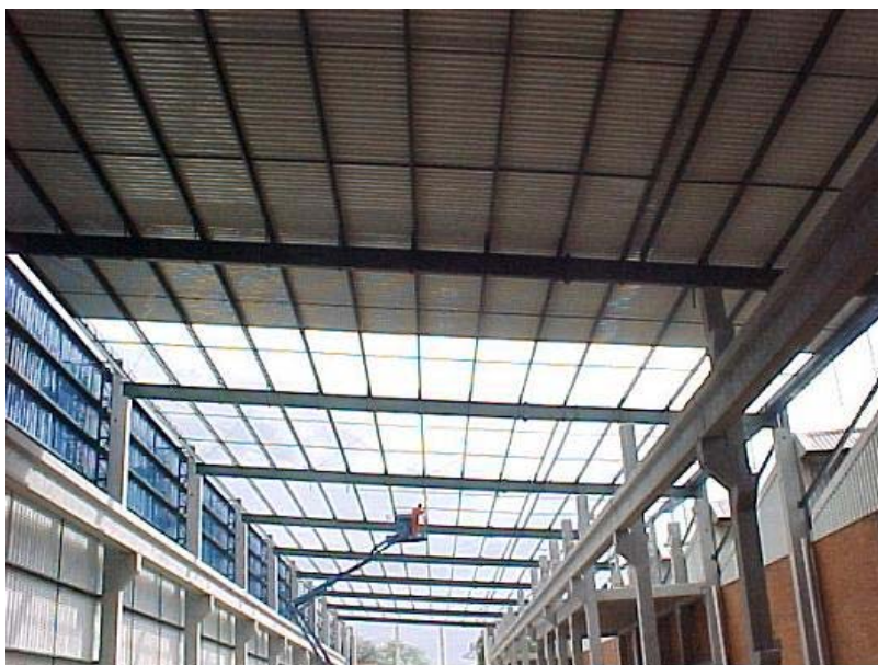
Figura 3 – Fotografia do empreendimento “a” em execução
