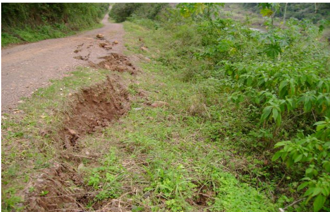
Figura 17: estrada no topo do corte- km 151+100
