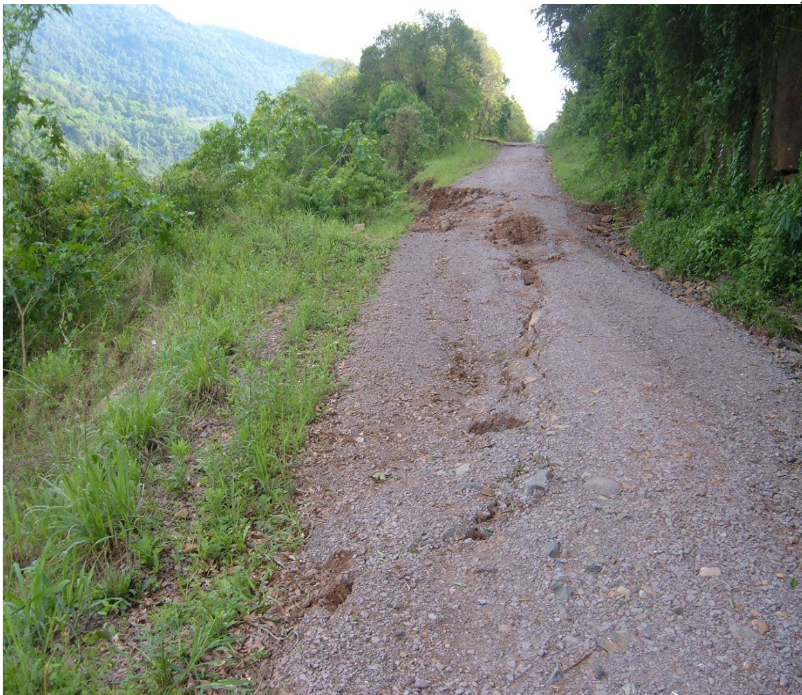
Figura 9: estrada no topo do corte- km 151 +100
