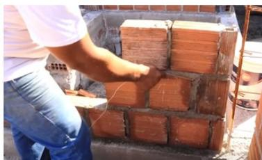
**Reposicionar a linha guia, utilizando os cantos já apurados e nivelados**
