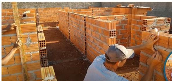
Utiliza-se uma **mangueira com água** para verificar se as fiadas estão alinhadas na altura entre os cantos e demais paredes.
