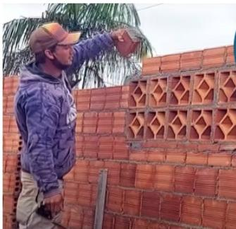
**Fiadas superiores:** Levantar o bloco acima da linha do ombro.
