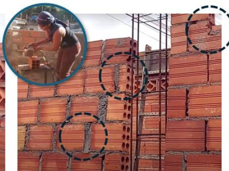
**Impossibilidade de coordenação modular:** compensação na massa e necessidade de quebra dos blocos
