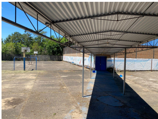
Figura 6. Acesso ao ginásio da escola. Fonte: Acervo pessoal.
