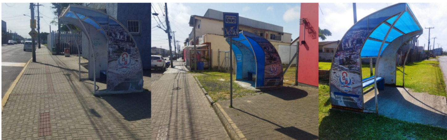
Figura 8: Paradas: 05, 06 e 07 respectivamente. Fonte: Fotos do Autor.
