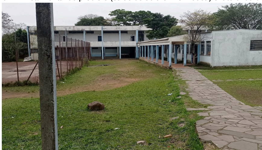
Figura 7 – Vista frontal do prédio 3 (salas de aula e informática) e lateral da direção
