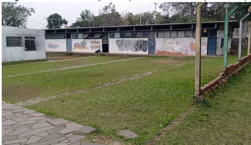
Figura 6 – Vista lateral do prédio 2 (secretaria e sala dos professores)
