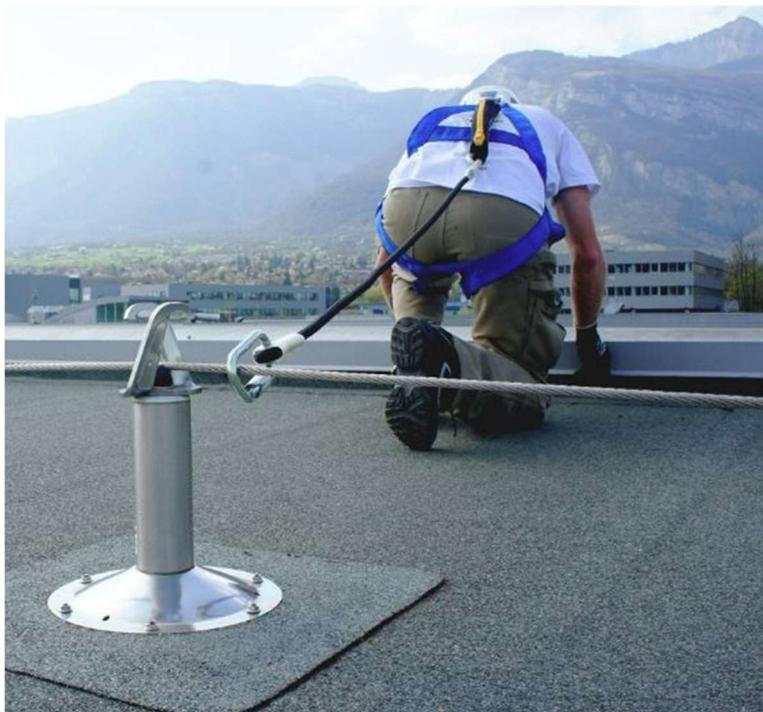
**Figura 18 - Sistema de ancoragem tipo C**
