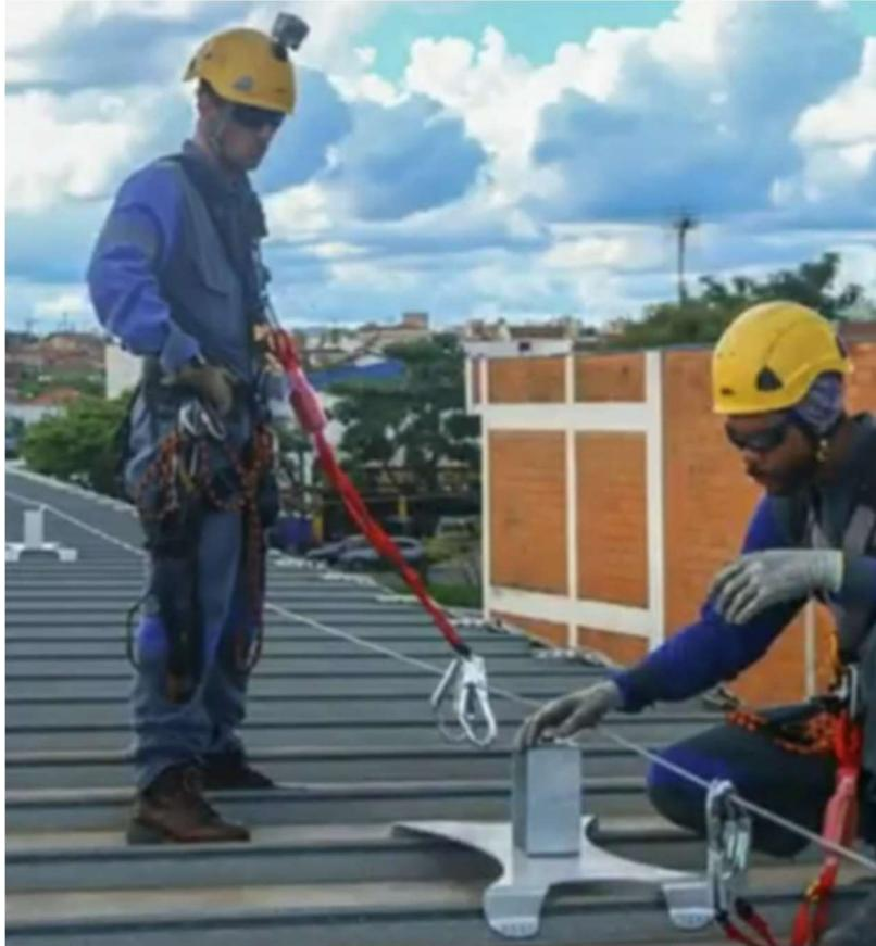
**Figura 17 - Sistema de ancoragem tipo C**
