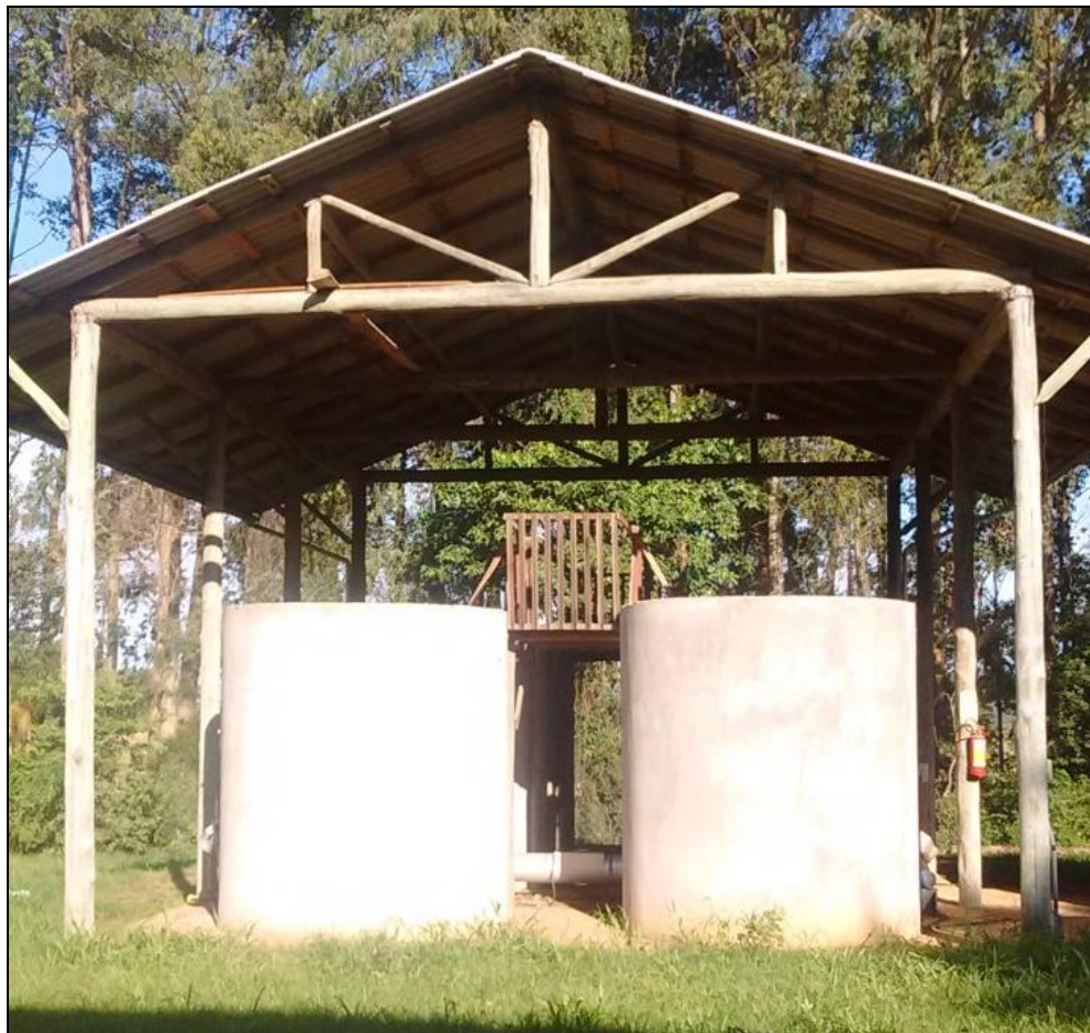
FIGURA 4. Silos secadores com capacidade de 6.000 kg. Eldorado do Sul, RS, 2017.
