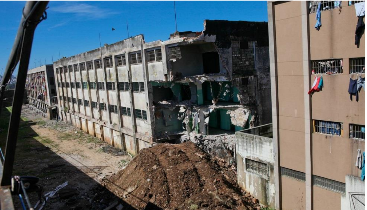
Foto 5 - Demolição começa pelo Pavilhão C
