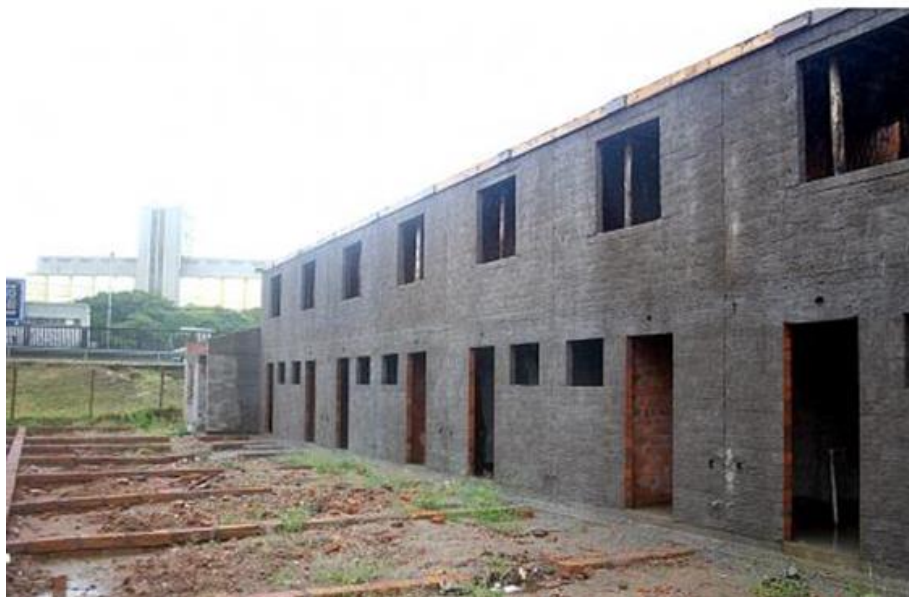
Figura 4 – Obras realizadas pela Prefeitura de Porto Alegre na Vila dos Papeleiros, como parte do Programa Integrado Entrada da Cidade (PIEC), em 17 de janeiro de 2006
