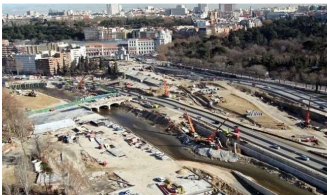
Figura 35 - Construção dos túneis da rodovia perimetral M-30
