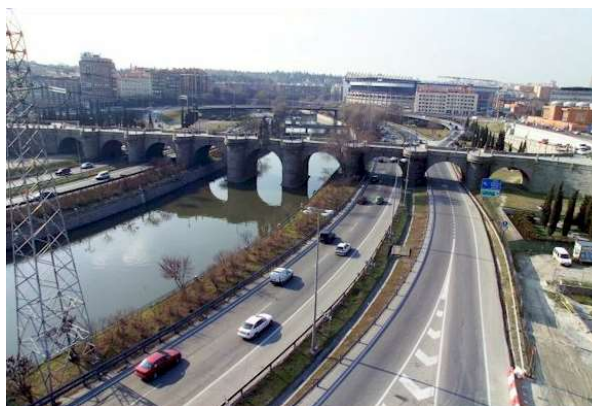
Figura 32 - Rodovia perimetral M-30 e a Puente de Toledo
