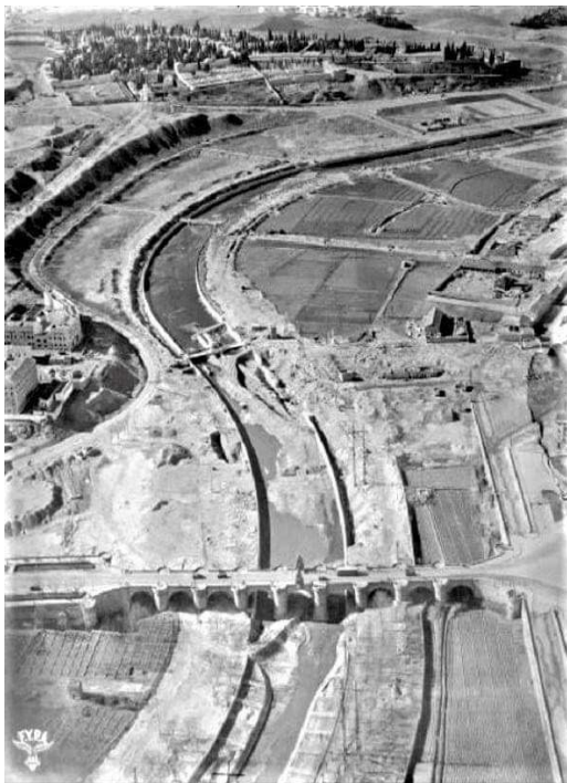
Figura 30 - Vista desde a Puente de Toledo e as obras de canalização, em 1957
