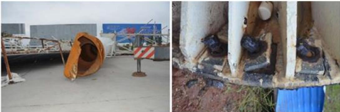
(c) Falha por instabilidade local ou global (d) Danos nos parafusos de ancoragem
