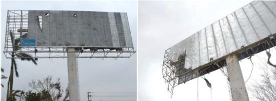
(a) Arrancamento do revestimento do painel (b) Falha da estrutura que sustenta a placa
