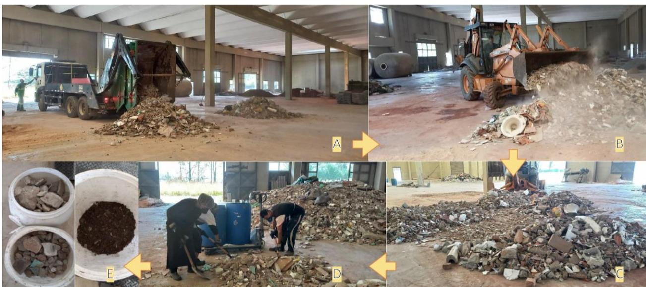
**Figura 1: Etapas dos estudos gravimétricos: descarregamento (A), homogeneização (B), organização da amostra (C), quarteamento (D), segregação dos tipos de RCC (E).**
