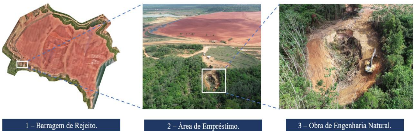
Figura 2: Local da obra de engenharia natural.
