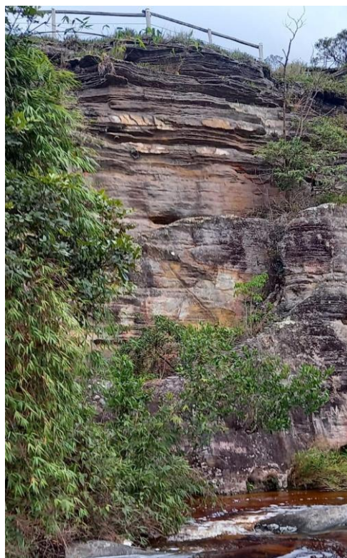
Figura 6: Guarda-corpo e os riscos do Paredão de Santo Antônio.
