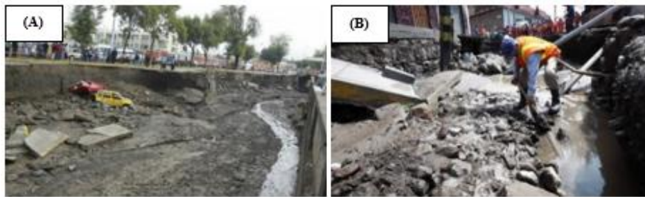
Figura 3: A) Calles invadidas de lodo por activación de quebradas posteriormente torrenteras. B) Vías destruidas como consecuencias de las inundaciones por acción de la intensa lluvia registrada. Fuente: Diario Correo (2013).
