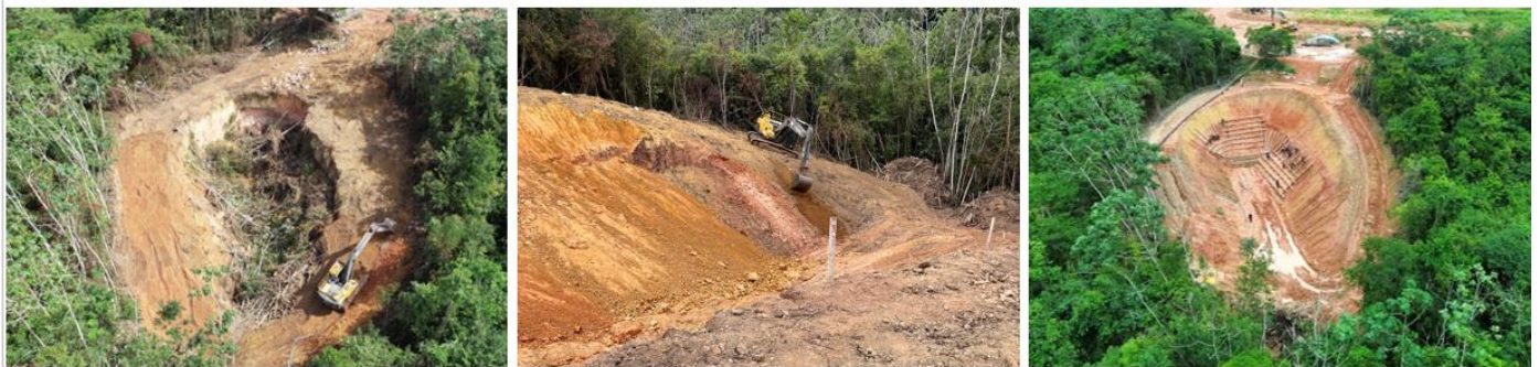
Figura 9: Execução da atividade de reconformação do terreno.
