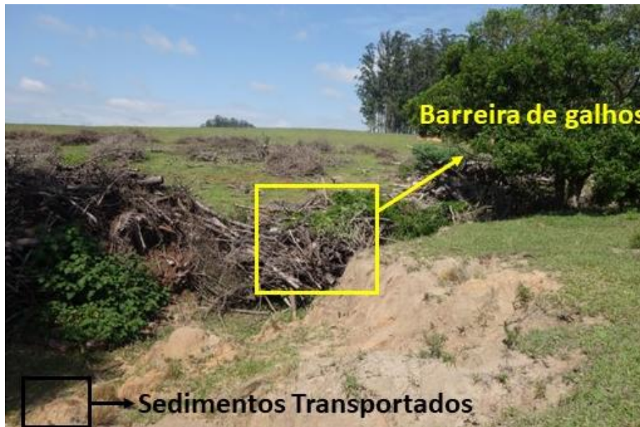
Figura 5: Exemplo de barreira de galhos aplicada ao longo do canal de drenagem.
