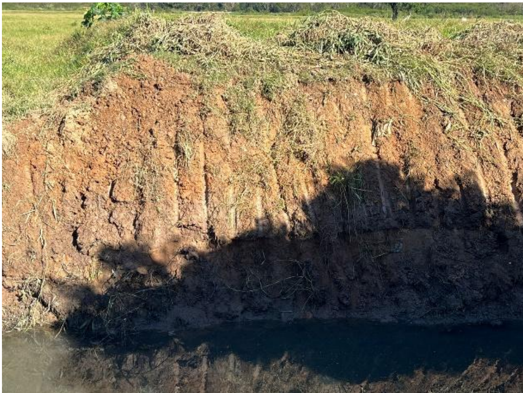
Figura 2: Corte realizado na encosta do rio pela prefeitura para ampliar o leito do córrego.
