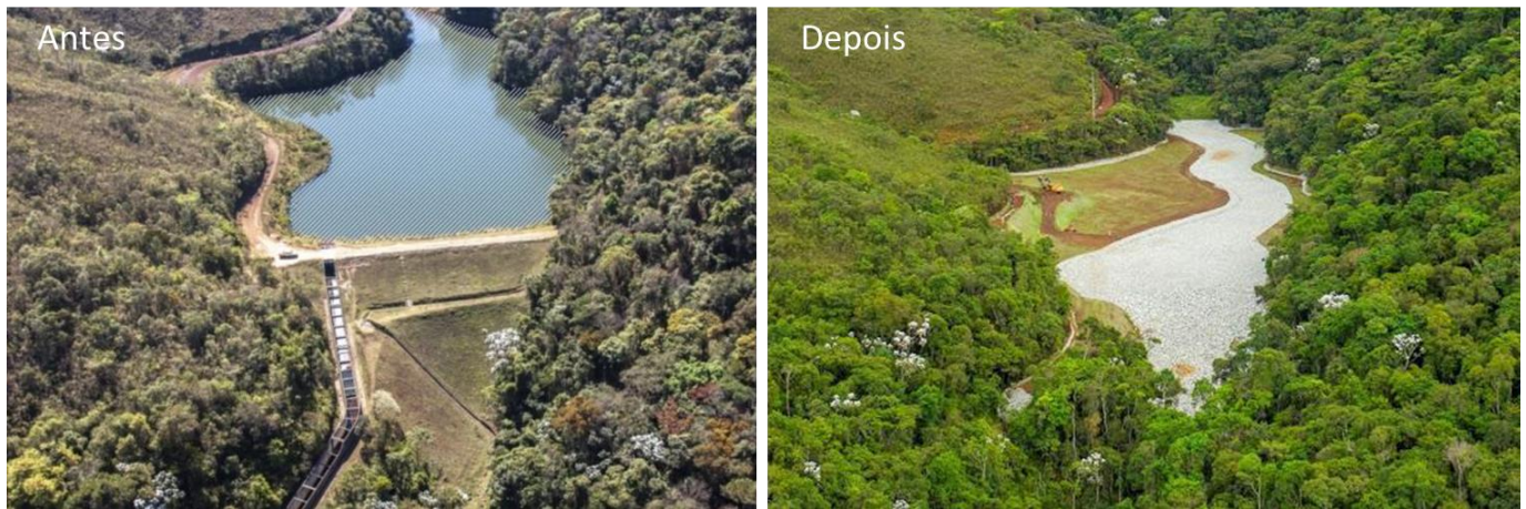
Figura 1: Descomissionamento da Barragem 8B da Vale.
