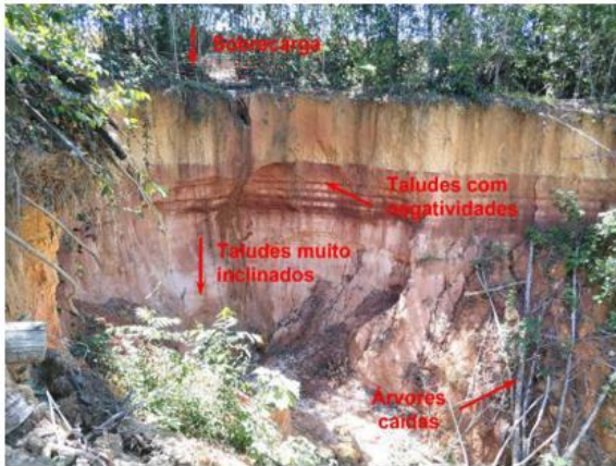
1 – Vista frontal da voçoroca (condições da área).
