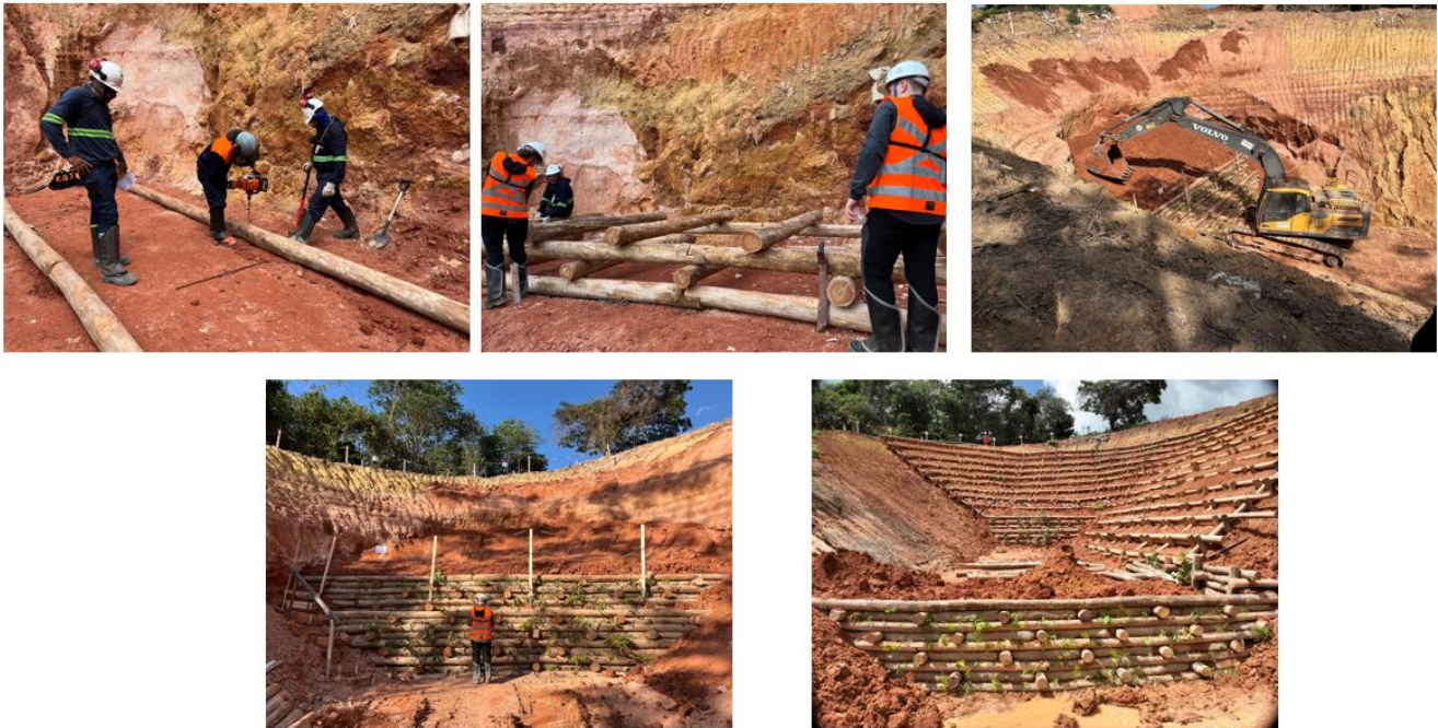
Figura 10: Execução da atividade do muro de suporte vivo dupla.
