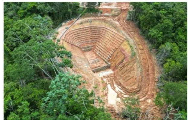
Figura 14: Execução da grade viva com processo erosivo controlado após altos índices pluviométricos sequenciais.
