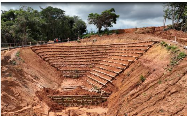
Figura 14: Execução da grade viva com processo erosivo controlado após altos índices pluviométricos sequenciais.
