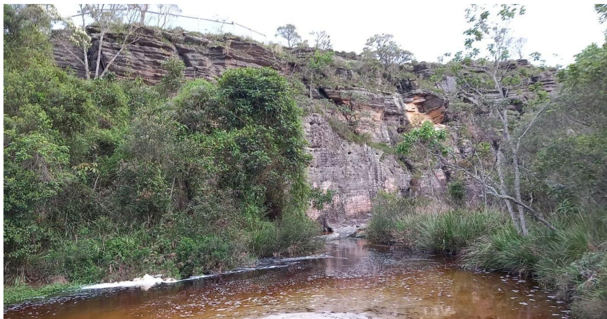
Figura 5 : Os riscos de queda no Paredão de Santo Antônio.
