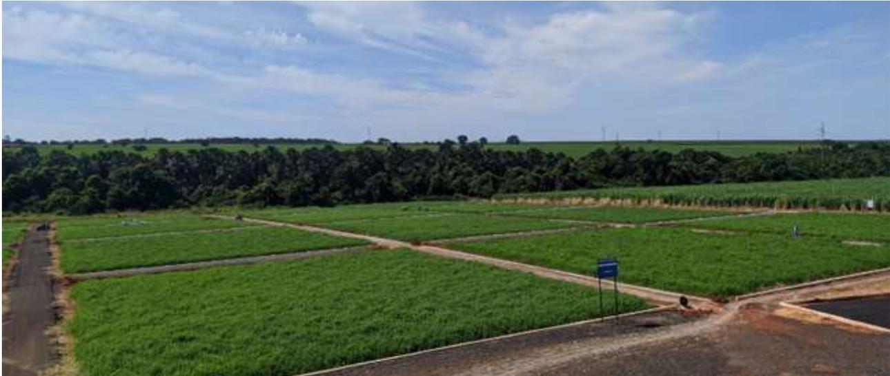
**Figura 5: Rampas de Disposição de esgotos ao solo (Escoamento à superfície).**
