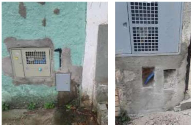
**Figura 4 - Exemplos de situações em que o posicionamento da UCQA não pôde ser realizado conforme a diretriz de localização prevista na NTS 363.**
