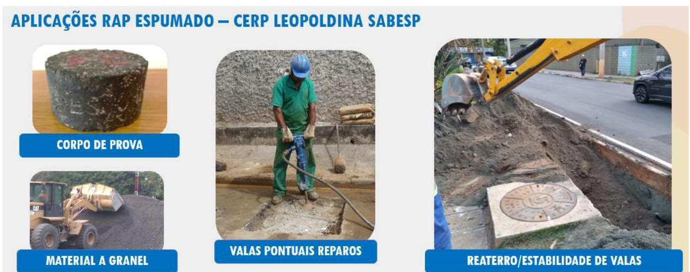
**Figura 1 - Material RAP espumado e aplicação em serviços de saneamento.**
