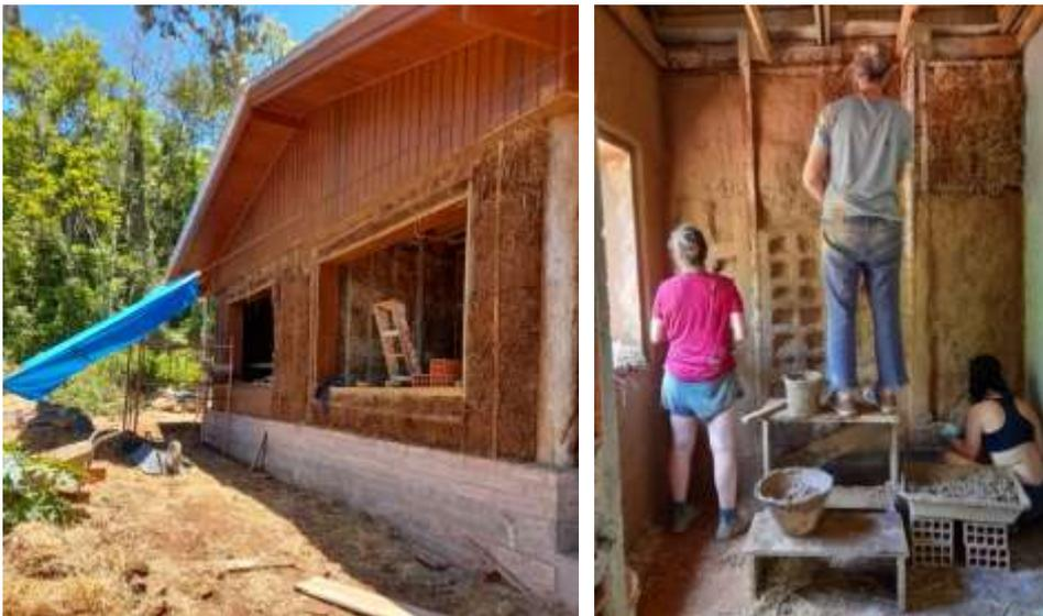
**Figura 4: Aplicação de barbotina e reboco grosso.**
