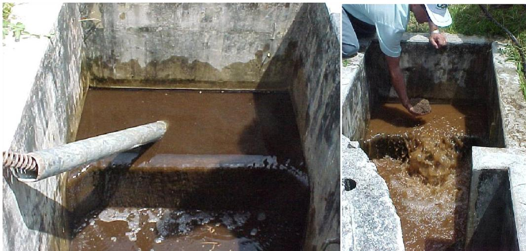
**Figura 5. Medidor de vazão no momento da limpeza da drenagem.**
