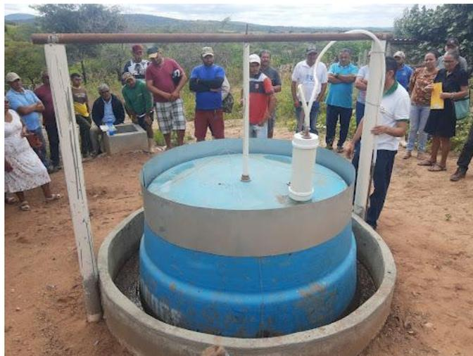
**Figura 4: Biodigestor do modelo sertanejo em Lajes Pintadas/RN.**
