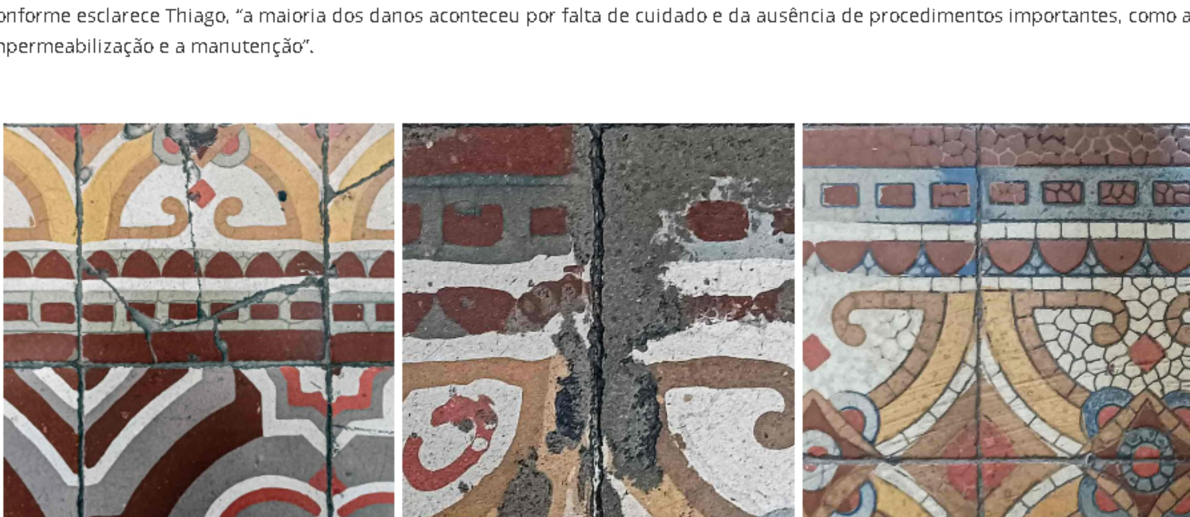
Na primeira parte do trabalho, pesquisador mapeou os danos presentes nos ladrilhos, como abrasão e rachaduras. (Foto: Thiago Thamy/Divulgação)
